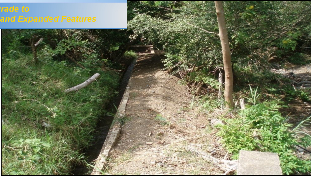
Foto No. 5-Canal de conducción aguas que ingresan a la bocatoma de la Quebrada Carbonera - Acuavalle S.A. Obras de captación sobre la Quebrada Villamaría
