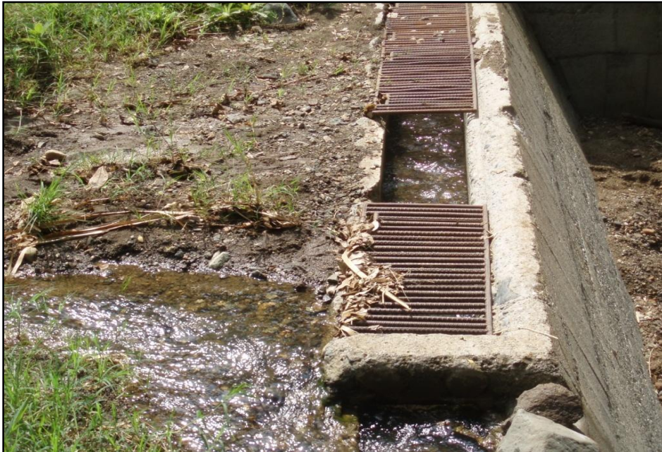
Foto N. 4: Bocatoma sobre la Quebrada Carbonero- Acueducto cabecera municipal de Vijos
