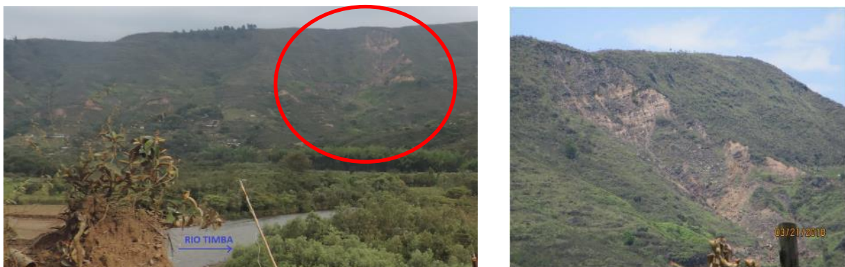
Fotografía 4-10. Caída de bloques de roca en sector minero (MI RIO TIMBA)
