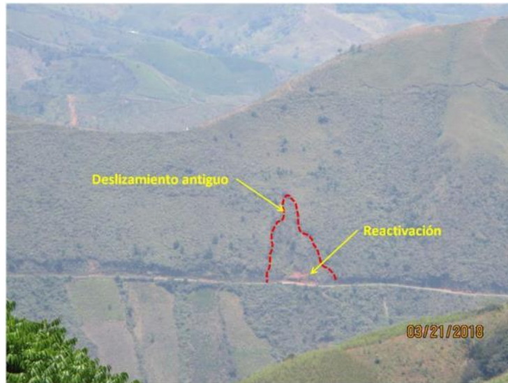
Fotografía 4-35. Reactivación de movimientos en masa en el talud de la vía Porvenir-Ceral
