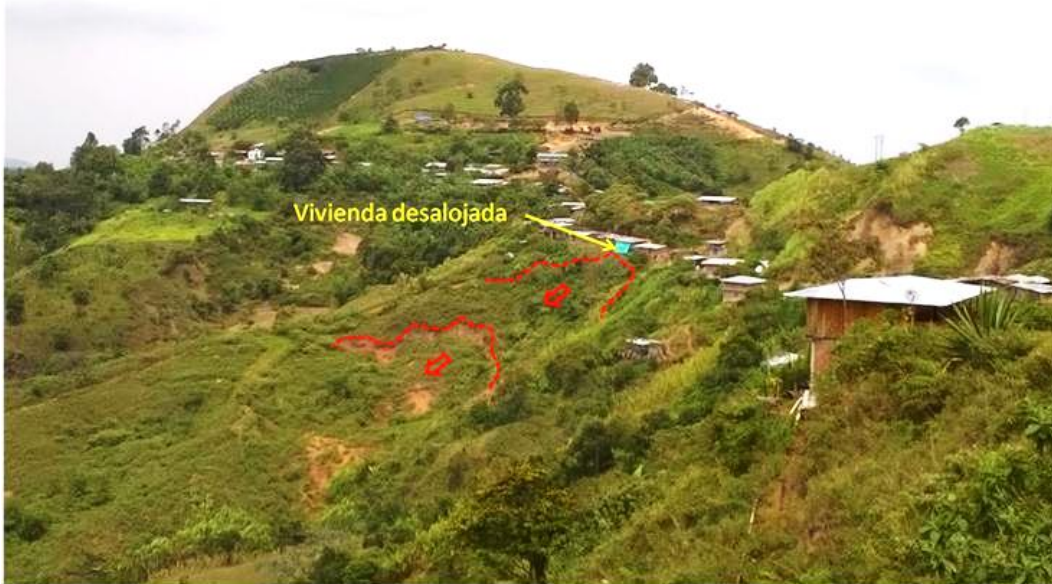
Fotografía 4-44. Movimientos de masa tipo deslizamiento por descarga de alcantarilla
