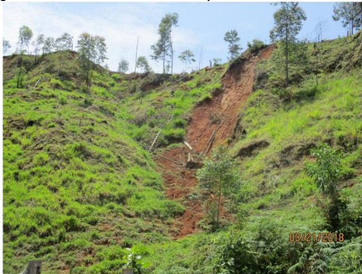
Fotografía 4-32. Movimiento en Masa de tipo deslizamiento en suelo residual
