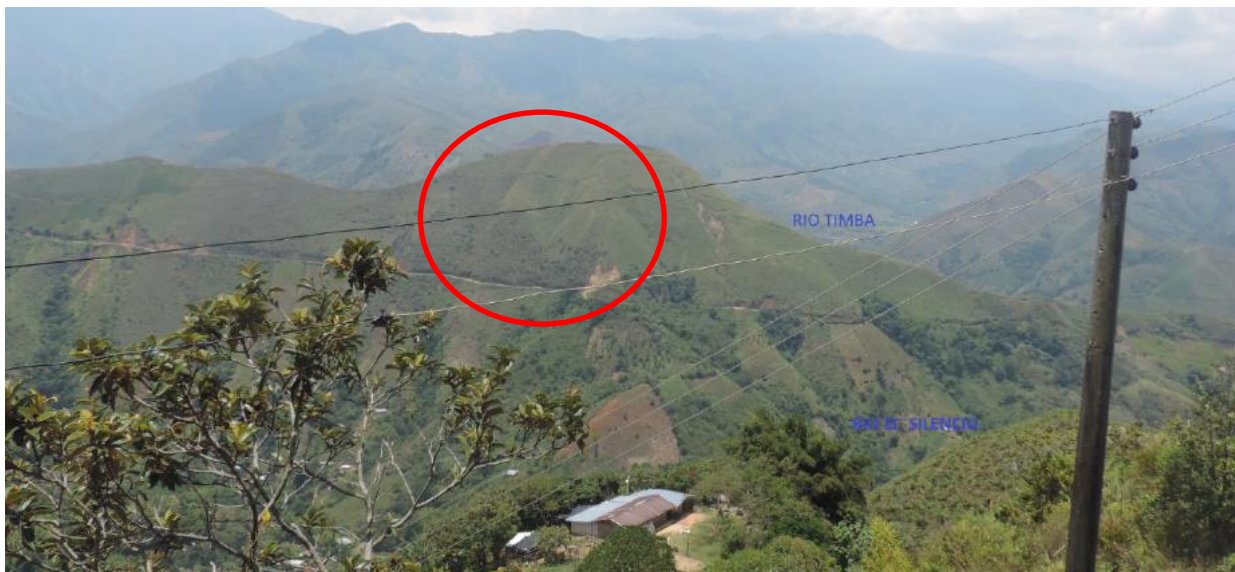
Fotografía 4-36. Movimientos de masa asociados a los cortes de talud y ampliación en cauces de quebradas- vía Porvenir – Ceral (MI Rio El Silencio)
