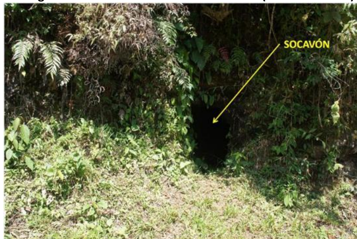
Fotografía 4-4. Socavón en la orilla de la vía (Minería de oro)
