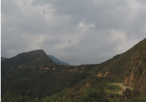
Fotografía 4-38 Cortes en la vía que conduce al Ceral
