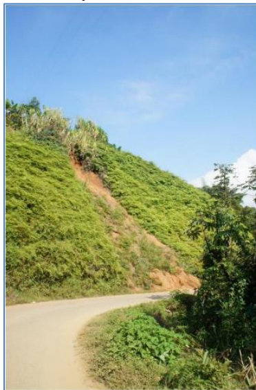
Fotografía 4-1. MM tipo Deslizamiento en suelo residual
