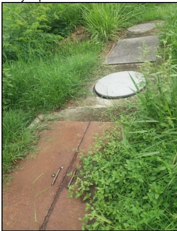
Fotos 3 y 4: Conformación del STARnD conformado por Trampa de Grasas, Tanque Séptico y Filtro Anaerobio
