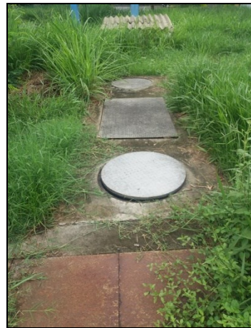
Fotos 3 y 4: Conformación del STARnD conformado por Trampa de Grasas, Tanque Séptico y Filtro Anaerobio
