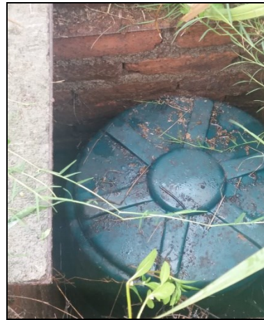
Foto 2: Sistema de Tratamiento de Aguas Residuales Domesticas - STARD (4000 Lts), punto donde el vector hace la recolección
