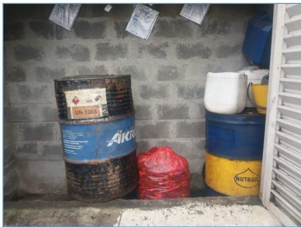
Foto 9. Cuarto de disposición de los Residuos Peligrosos
