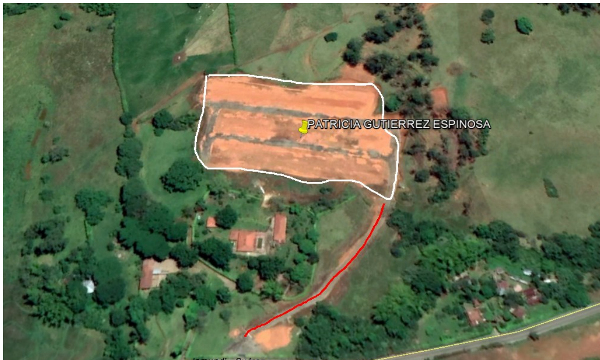
Registro fotográfico, Las explanaciones y la vía ya construidas
