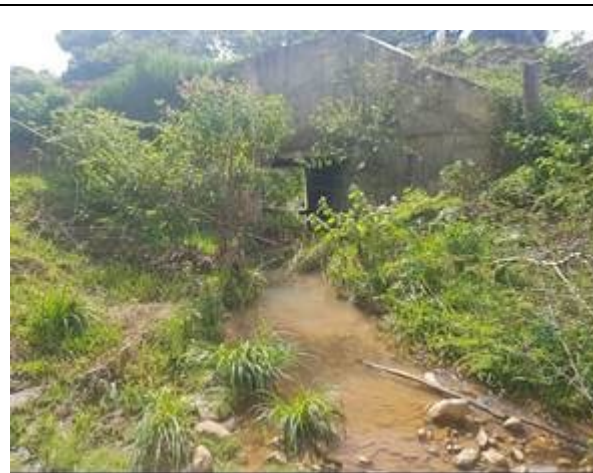
Box culvert terminado
