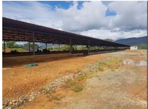
Se construyen los galpones
