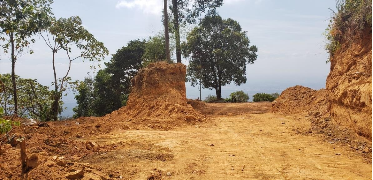
Foto 1. Entrada al predio. Explanación realizada con maquinaria pesada.
