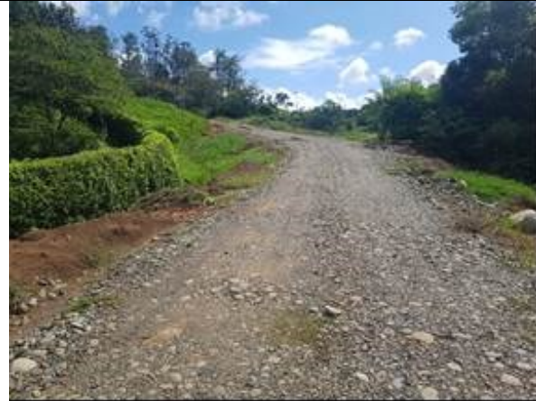
Vía construida con capa de piedra de canto rodado
