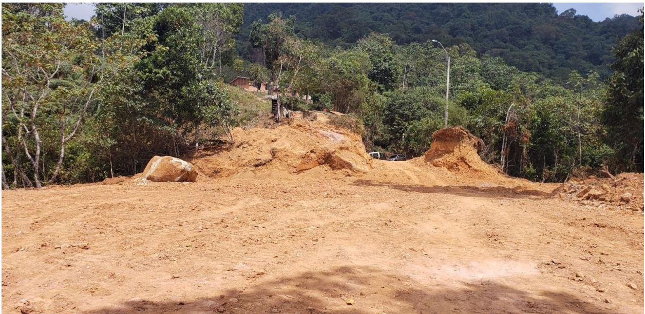
Foto 2. Explanación realizada al interior del predio (zona achurada en rojo Figura 2).
