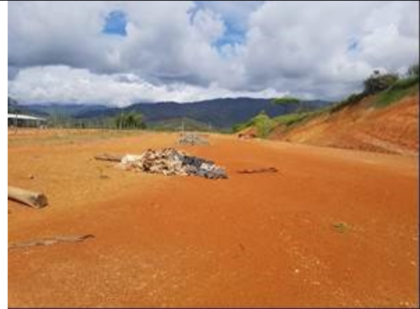
Las tres explanaciones ya construidas y conformadas
