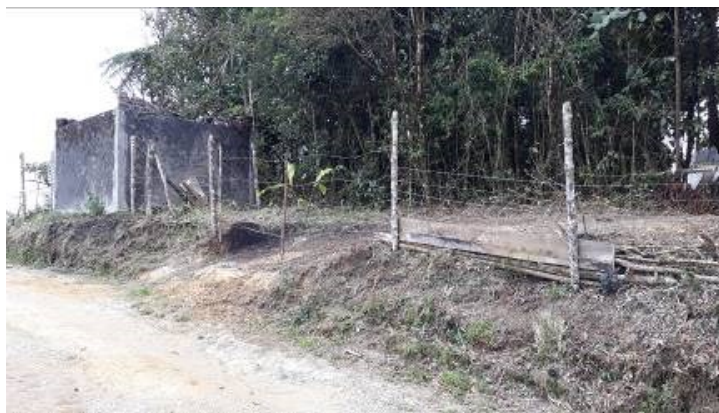
Fotos 3-4. Adecuación de entrada al predio con erradicación de vegetación existente
