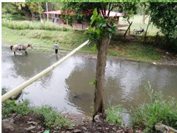
Foto 3. Obras que se ejecutan con el fin de minimizar el riesgo que ofrece el cauce sobre el sitio aledaño a la vivienda.
