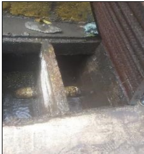
Foto 7 y 8: Trampas de grasas con dos compartimientos
