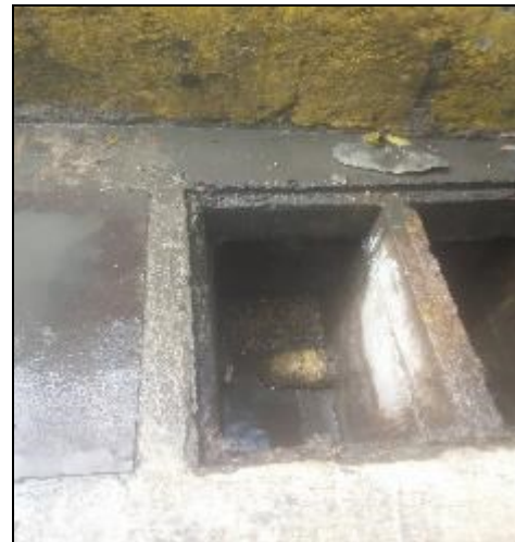
Foto 7 y 8: Trampas de grasas con dos compartimientos
