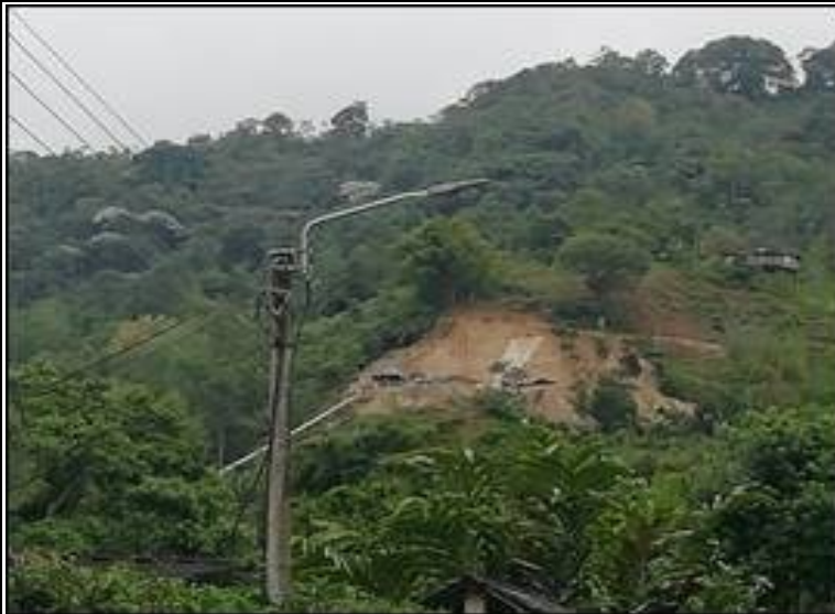
Foto 1. Panorámica de la obra dentro del macizo rocoso, sobre una divisoria existente dentro de micro cuenca (relieve ondulado)
