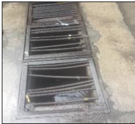
Fotos 5 y 6: Trampas de grasas con triple compartimiento
