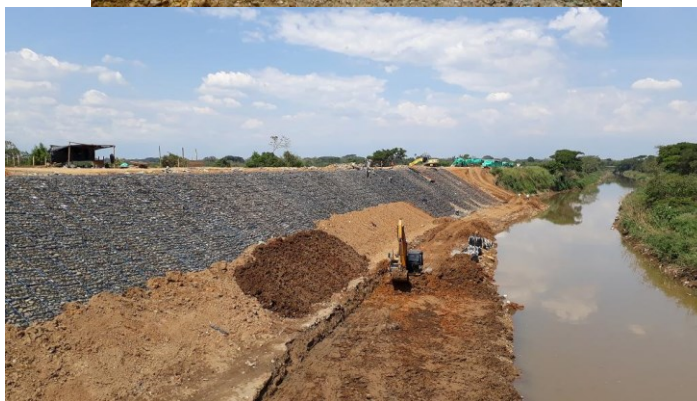
Imágenes 12 y 13. Obras de reforzamiento del Jarillón del río Cauca (Fuente: CVC, 2018)
