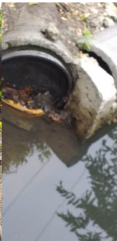
Imagen donde se aprecia la tapa que detiene el agua para la comunidad
