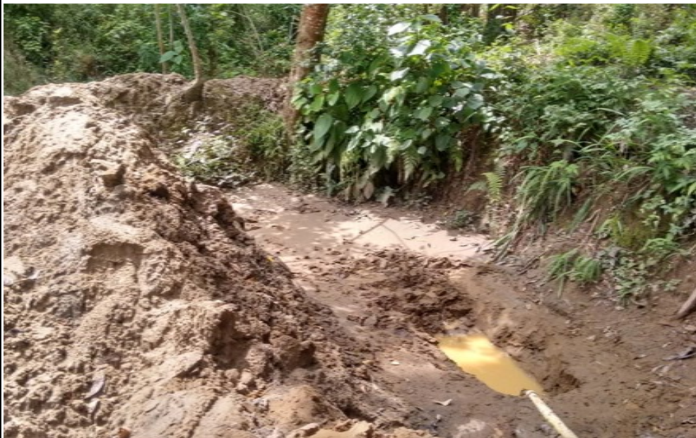
Fotos 1 . Ubicación del socavón 1. Fuente CVC.
