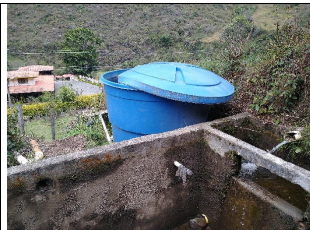
Foto 1. Punto de captación – Fin de acequia.
