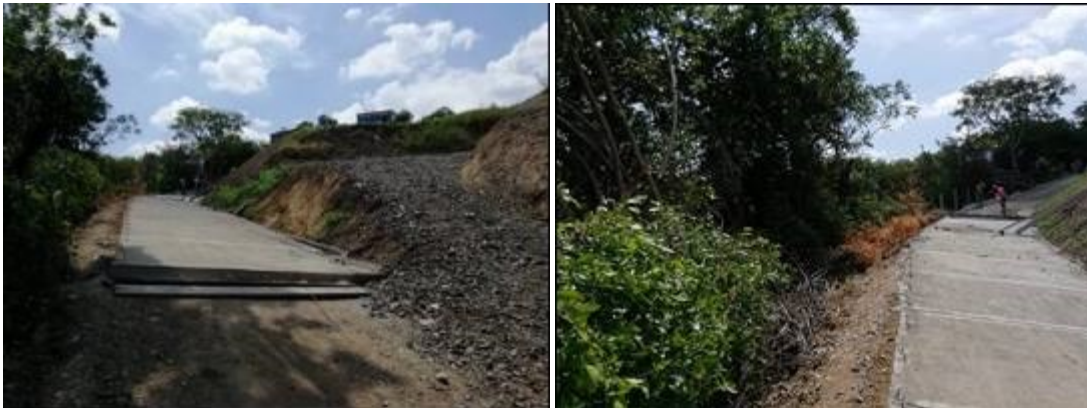
Fotos 17 y 18: Pavimentación en desarrollo de vía interna principal que conduce a parte alta topográfica del predio
