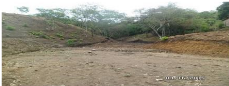
Foto 2: Foto tomada de informe del año 2015, en la que se muestra la intervención del drenaje natural, evidenciándose explanación y corte del macizo rocoso en varios tramos de la margen izquierda del drenaje.
