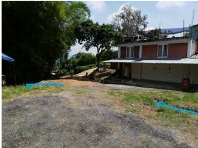
Foto 16: Casa nueva o remodelada (?), la cual se encuentra dentro de zona forestal protectora de drenaje natural.
