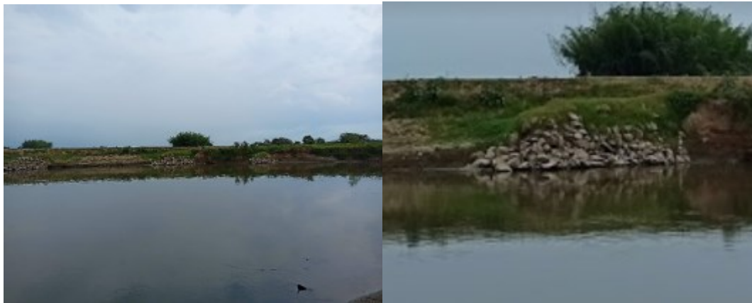
Imágenes 6 y 7, intervenciones realizadas en margen derecha del Rio Cauca
