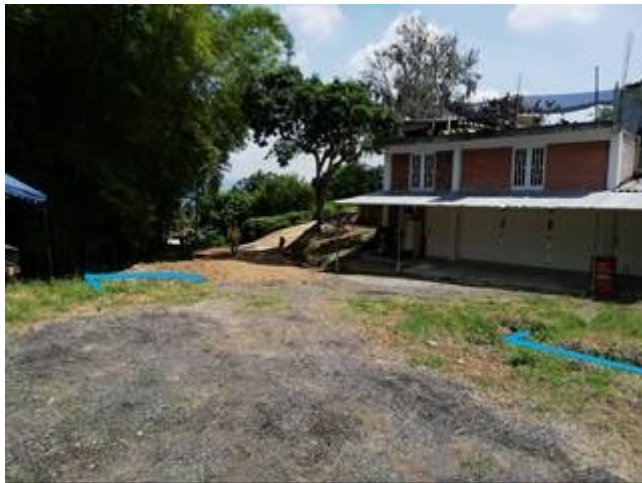
Foto 16: Casa nueva o remodelada (?), la cual se encuentra dentro de zona forestal protectora de drenaje natural.
