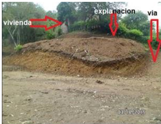
Foto 10: En la foto tomada en el año 2015, se señala tanto la vivienda lindero del predio La Italia, como la explanación y la apertura de vía para realizar la explanación.
