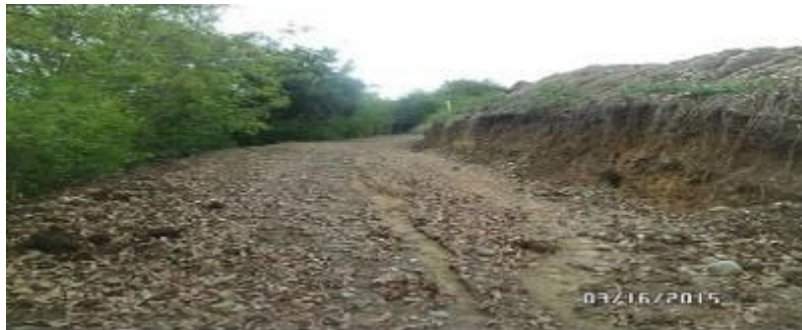
Foto 1: Foto tomada de informe del año 2015, en la que se muestra la vía de acceso a las explanaciones realizadas en la parte superior del predio. En el informe se señala que las pendientes no son superiores al 5%.
