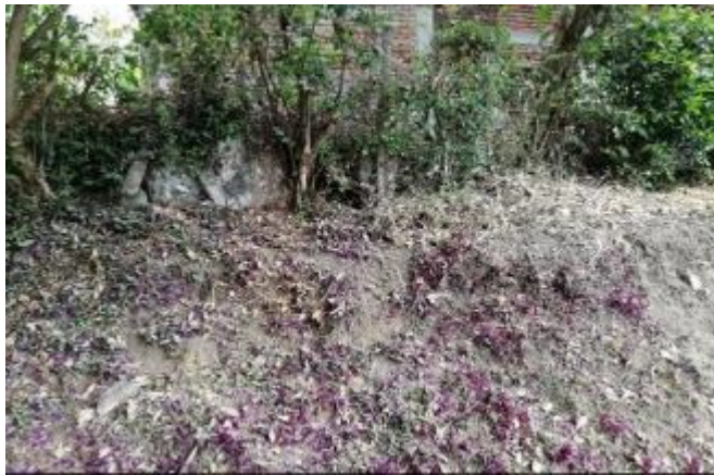
Fotos 13, 14 y 15: en las fotos se señala la explanación y la cercanía a la vivienda del predio lindero, indicando el grado de riesgo de probable afectación de la estructura.
