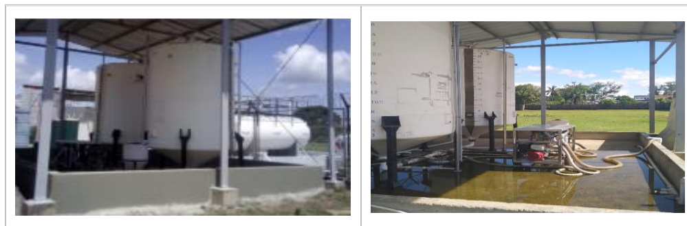
Fotografía 2.4-23 Instalaciones de preparación de la mezcla
