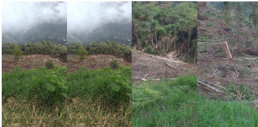
Imágenes de la adecuación de terreno y de la madera aserrada.
