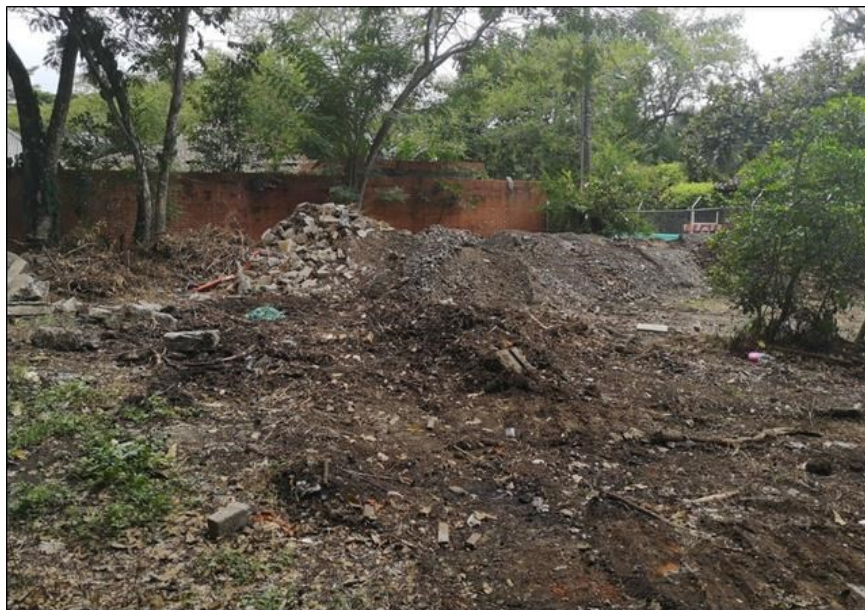
Foto 9. Sitio donde se encuentran depositando escombros resultantes de la excavación
