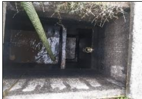
Fotos 3 y 4. Estado actual del lecho filtrante en la unidad FAFA
