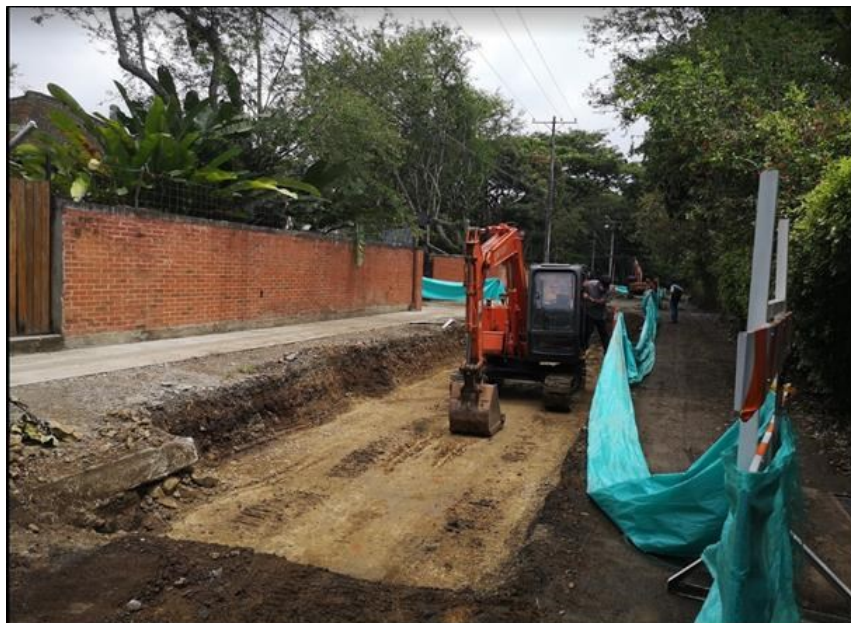
Foto 6. Movimiento de tierra y excavación de para adecuación de vía, frente a la Fundación Valle del Lili Parcelación Andalucía - Calle 50 Cra 118
