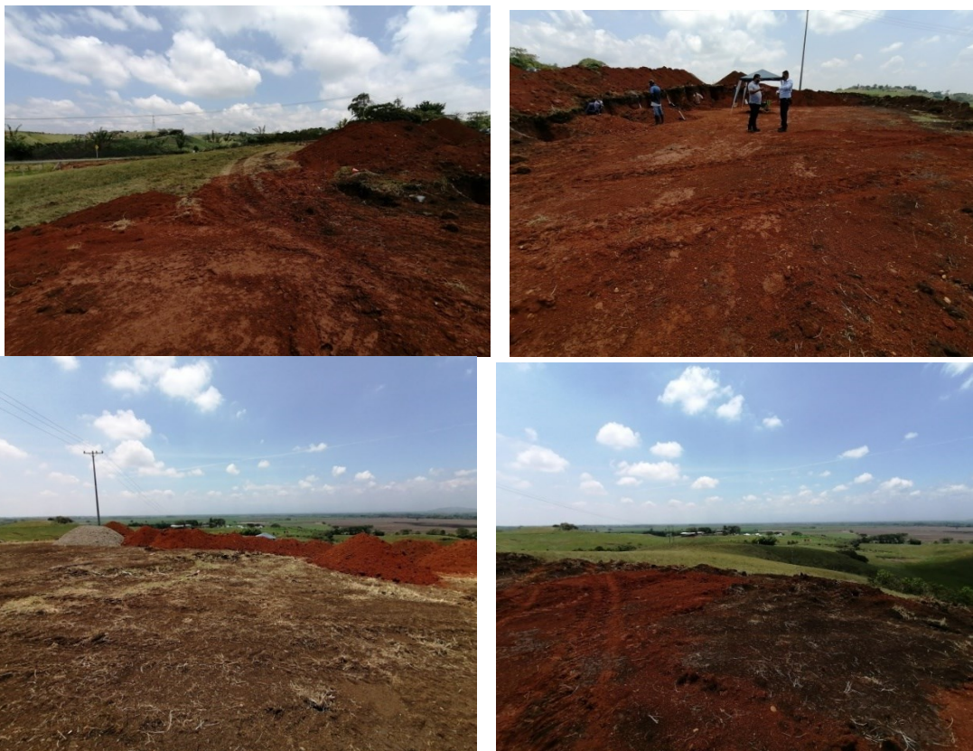
Imágenes 3, 4, 5 y 6. Evidencia del 24 de agosto de 2020 donde se observa la explanación realizada al interior del predio.
