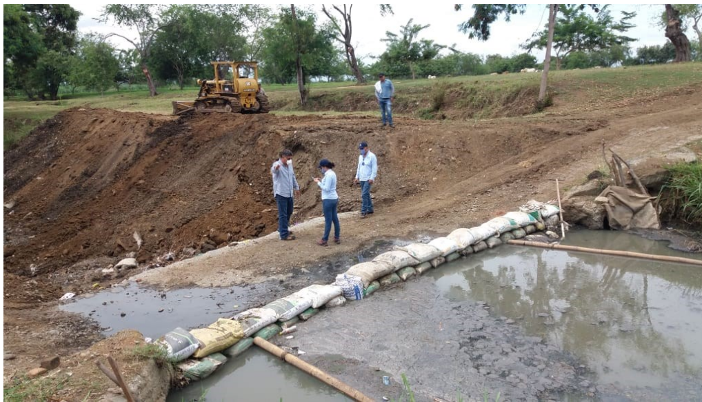
Foto 2. Interrupción y desviación del río Yumbo, con costales de tierra. Al fondo maquinaria varada.
