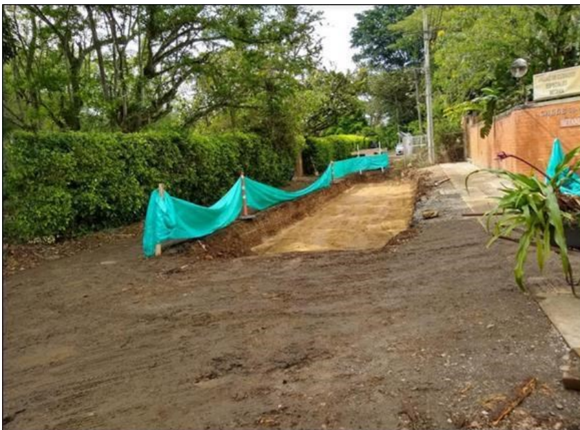
Foto 3. Excavación para adecuación de vía, Parcelación Andalucía - Calle 50 - Cra 118
