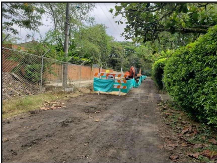
Foto 4. Cerramiento para realizar actividades de excavación - Parcelación Andalucía - Calle 50 - Cra 118
