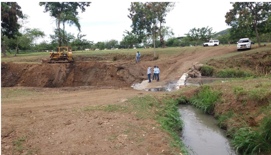
Foto 4. Disposición de la tierra con maquinaria tipo Bulldozer sobre la margen derecha del río Yumbo.
