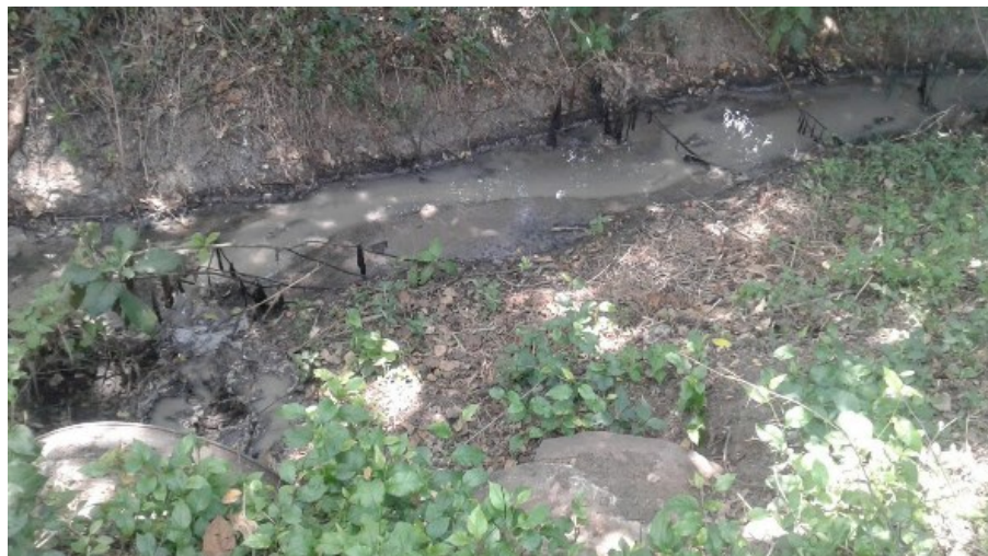
Ilustración 13 Entrega de la quebrada Guabinas por tubería al cauce de la quebrada La Rafaela.
