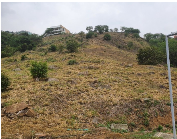
Foto 1. Frente del predio Lote 2 CVC. 2019
