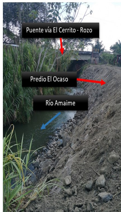
IMAGEN 3 - Talud del dique recuperado con enrocado
