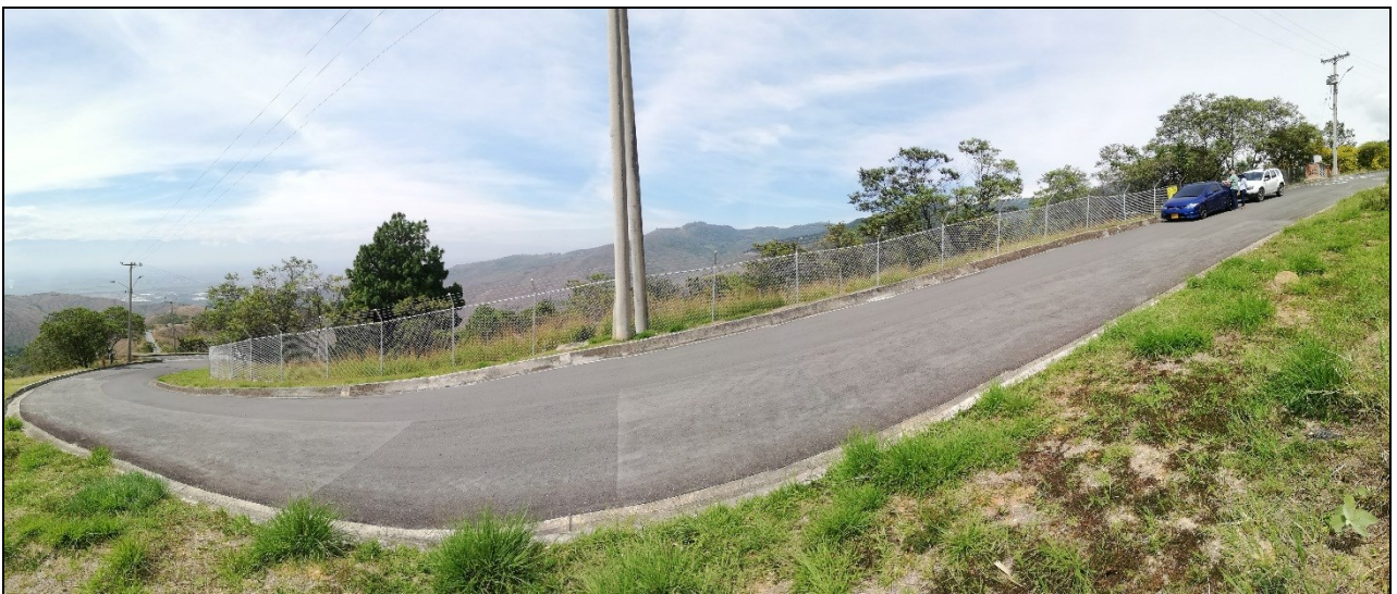
Foto 5. Vista general exterior del Lote 22 – Parcelación Lomas de Dapa. CVC 2020
