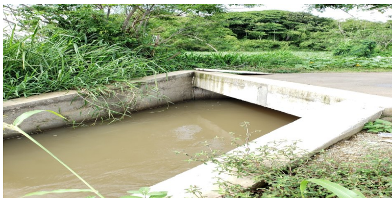
Foto 7. Salida de la acequia el comunero del Box Culvert, ingreso al predio del proyecto Ciudadela Las Flores.
