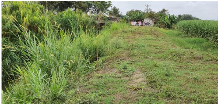
IMAGEN 6 – Cobertura vegetal en el cauce a la altura del punto 1
