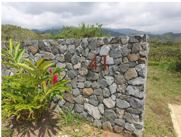
Entrada al predio
