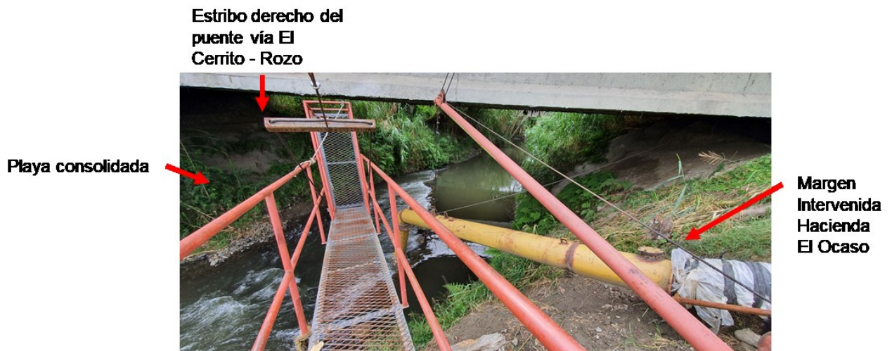
IMAGEN 5 – Río Amaime a la altura del puente vía El Cerrito - Rozo
