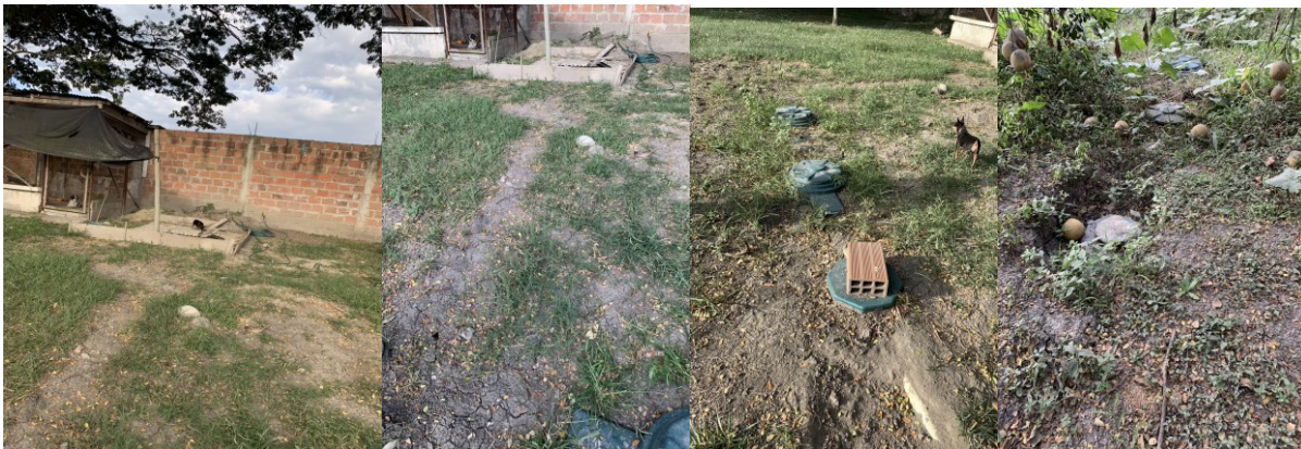
Registro fotográfico. Ubicación de los S-TARD instalados para la casa principal y Caseta de Bioseguridad
