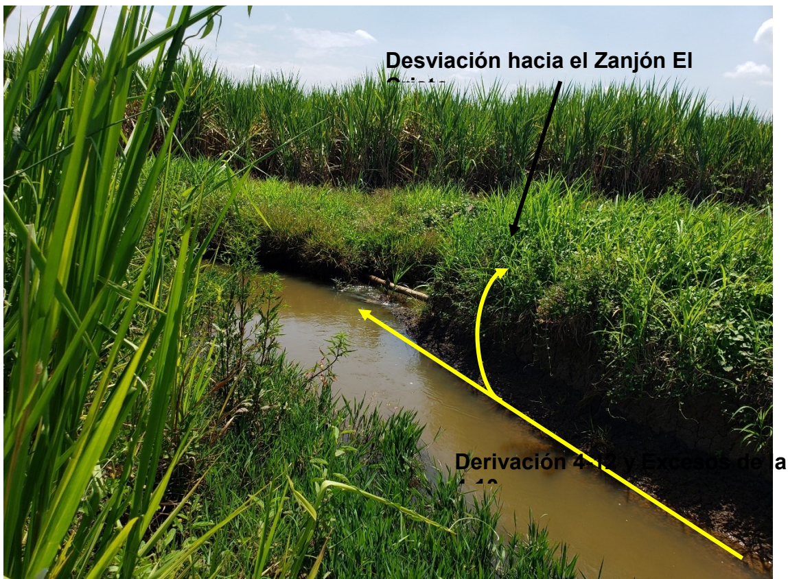
Foto 10. Tránsito 2 (Total), ubicado inmediatamente después de la estructura de reparto #2
