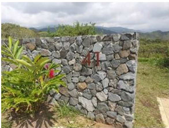
Entrada al predio
