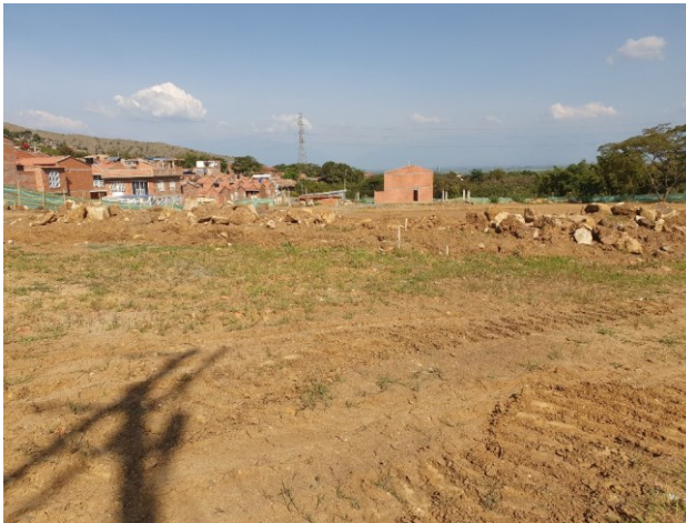
Foto 3. Vista panorámica donde se va a realizar la nivelación de terreno CVC 2020
