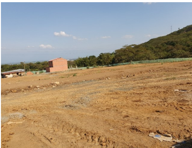
Foto 3. En este sitio se construirá un conjunto cerrado habitacional denominado Brisas del Campestre CVC 2020
