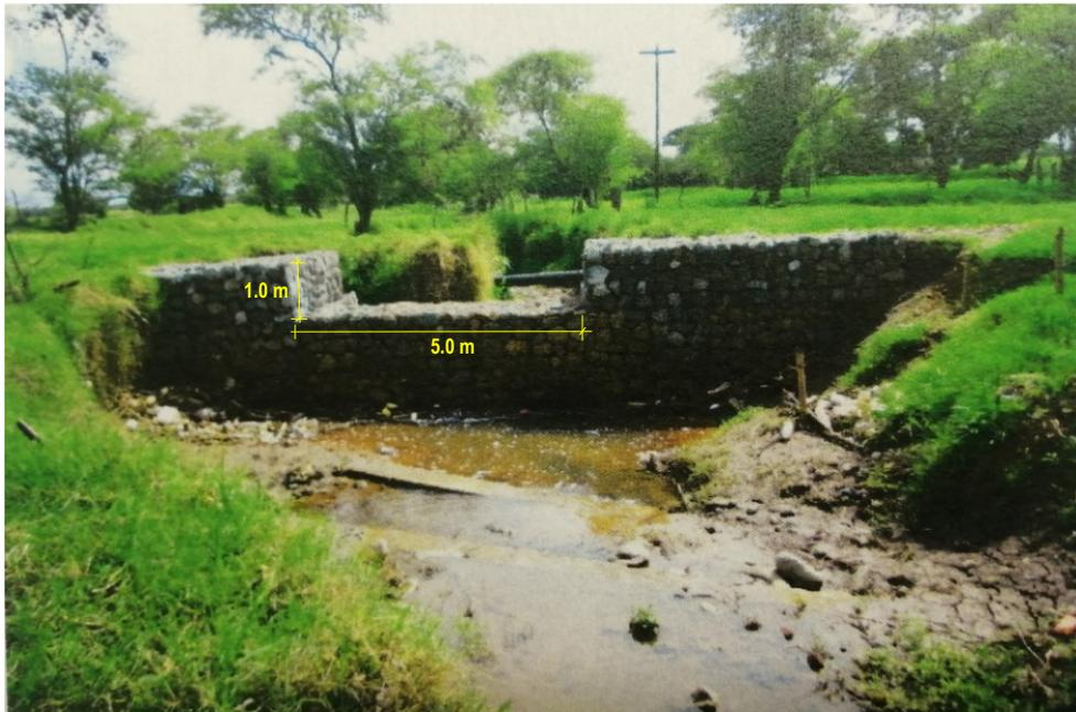
Imagen No. 6. Obsérvese la configuración final de la obra de protección propuesta, en donde el área aproximada del vertedero se materializó en 5m<sup>2</sup> y el nivel de fondo que se inducía por la sedimentación aguas arriba (que coincide con el nivel del vertedero) se materializó un metro por debajo del nivel de las banca izquierda y derecha.
