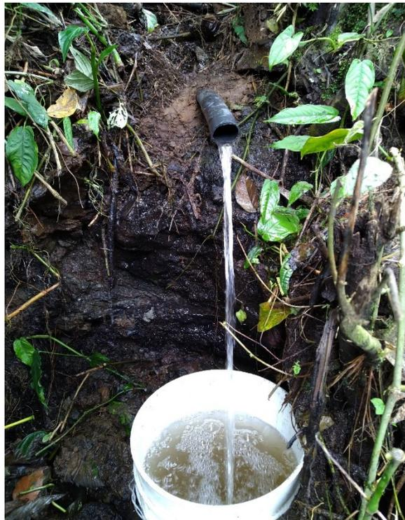
En estas dos (2) fotos podemos observar el sitio donde se construirá la bocatoma y el aforo volumétrico que se utilizó para calcular el caudal, el cual será conducido en tubería plástica de una (1") pulgada hasta un tanque de almacenamiento.
