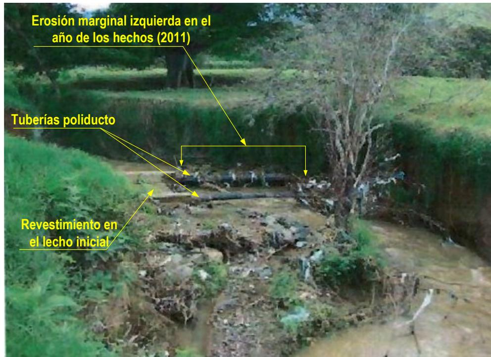
Imagen No. 5. Obsérvese las tuberías del poliducto expuestas por la socavación y erosión, principalmente hacia la margen izquierda y el revestimiento en concreto que la corriente no puede mover, por lo cual se genera la inestabilidad. Tomado: Expediente, informe Agosto de 2011, INGENIERÍA Y GEOTÉCNICA LTDA.
