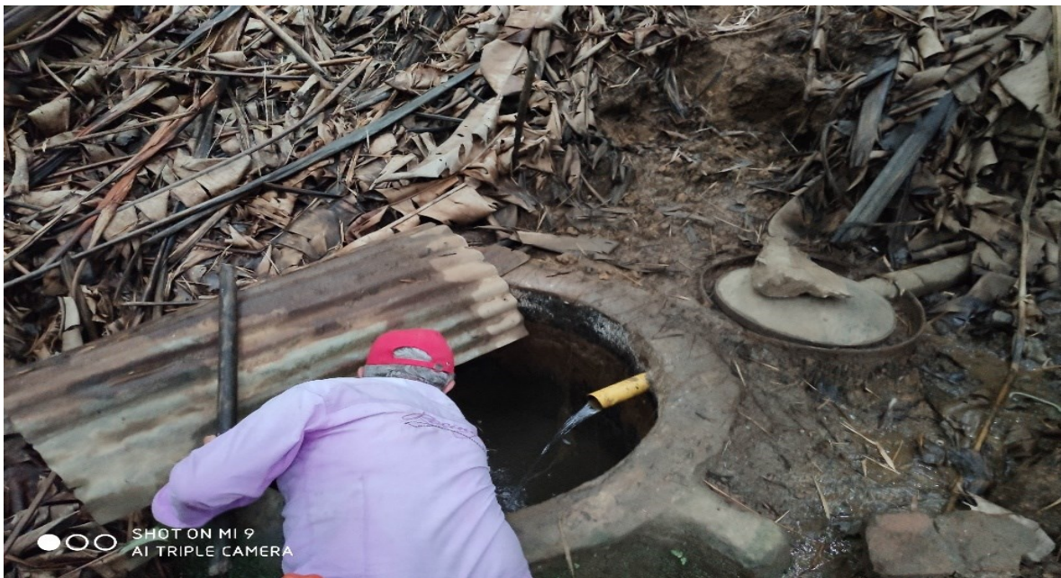
Tanque inicial captación desarenador del predio La Esperanza
