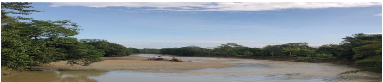
Foto No.1 Extracción y cargue de material pétreo de mecanizada sobre el río Dagua – Sector Zacarías. Coordenadas 3°48'54.09" N – 77°0'25.22" O Fecha: 30 de enero de 2020
