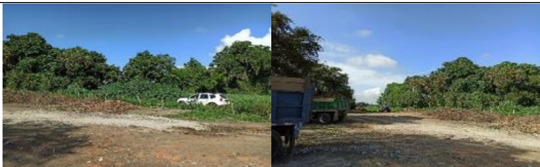
Imagen 6 y 7, Disposición de Material terreo, Fuente propia.
