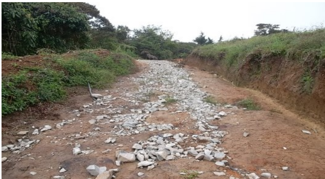
Foto 2. Apertura de vía en el predio La Tribuna. San Pedro (Valle)
