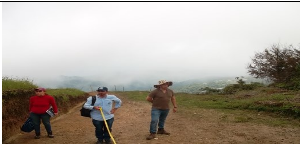
Foto 1. Apertura de vía en el predio La Tribuna.
