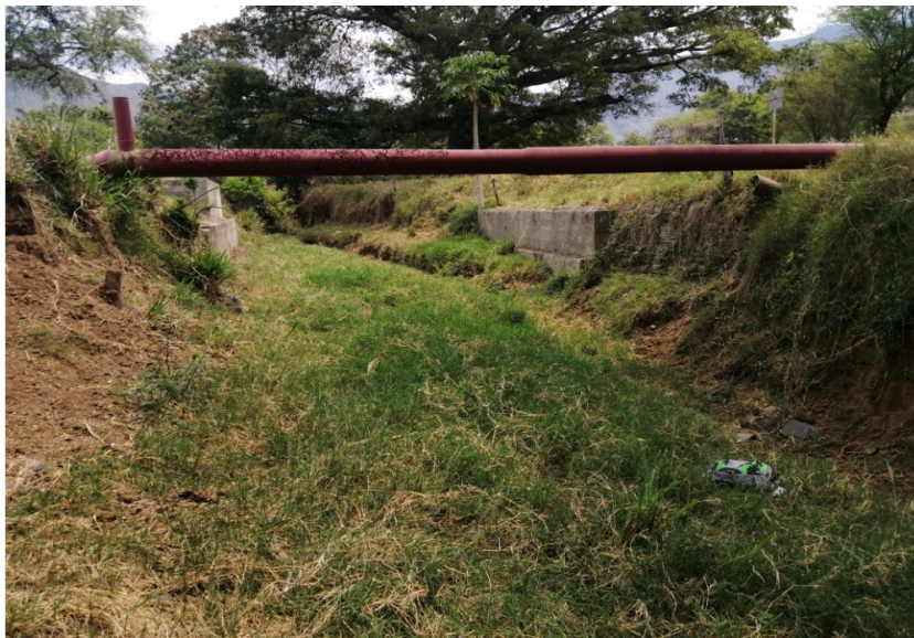
Imagen No. 4. Vista aguas hacia aguas arriba sitio de interés cruce poliducto Cartago – Yumbo con el cauce del río Vijes.
