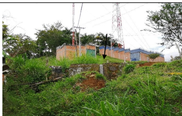
Foto 4: Tanque de distribución de agua de la derivación 1 de la Quebrada Los Negros para el llenado del lago y otros usuarios.
