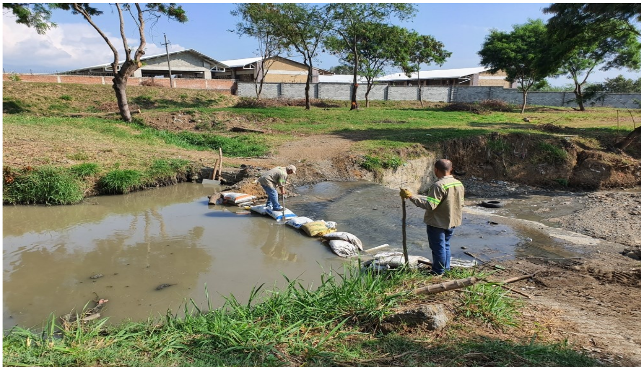
Levantando el trincho con trabajadores de la ESPY en el rio Yumbo, restableciendo el caudal ecológico del rio
