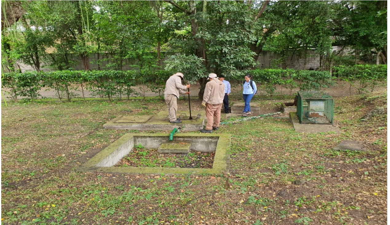
PTARD por fuera de operación
