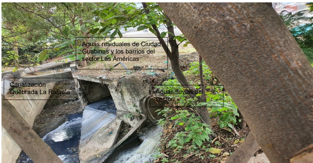
Ilustración 2 Descarga de aguas sobre la quebrada La Rafaela
