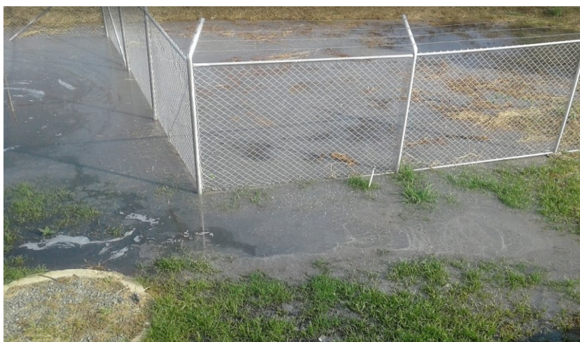
Ilustración 4 Inundación de aguas residuales y traza de grasas
