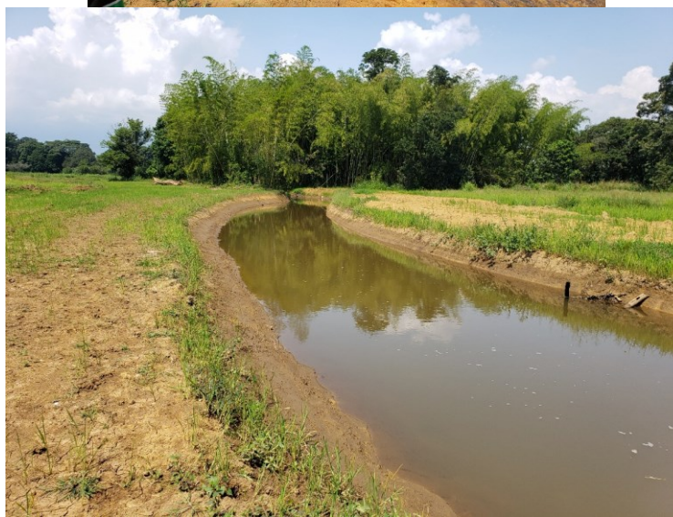
Foto 2. Intervención sobre el Zanjón Villegas. Fotografía tomada aproximadamente en la abscisa 2+634, en dirección aguas arriba del Canal. Visita Técnica 10/12/2019
