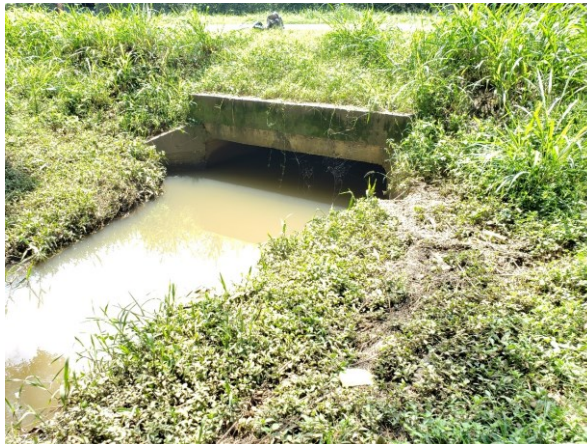
Foto 6. Estado del Box Culvert en la vía Panamericana cuando
