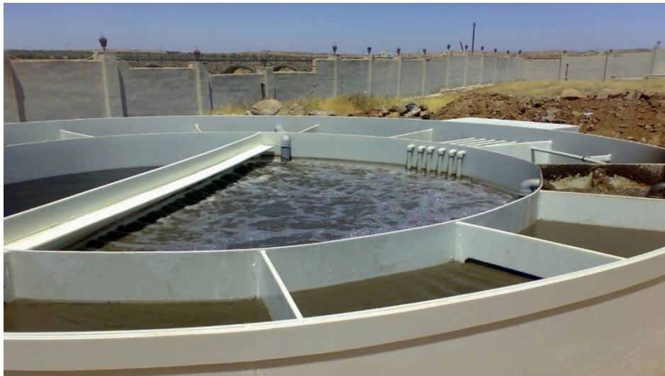
Imagen 3. PTAR ESTAR 125™ Reactor biológico.
