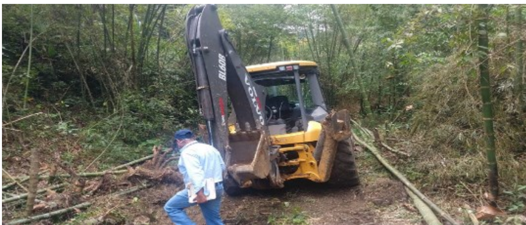
Foto No. 1 y Foto No. 2 se evidencia la maquinaria utilizada en la actividad.
