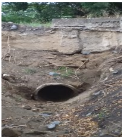
Fotos 4 - 5. Se observa la boca o entrada de la tubería del canal de drenaje y la salida del mismo, después de la limpieza del material que se había desprendido
