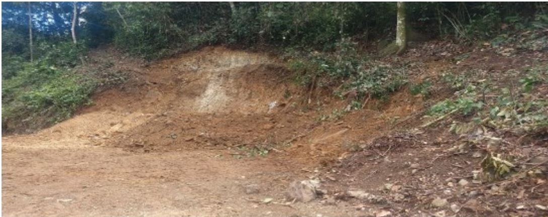
Foto 1 - zona intervenida con maquinaria, en suelos con pendientes mayores al 45%.
