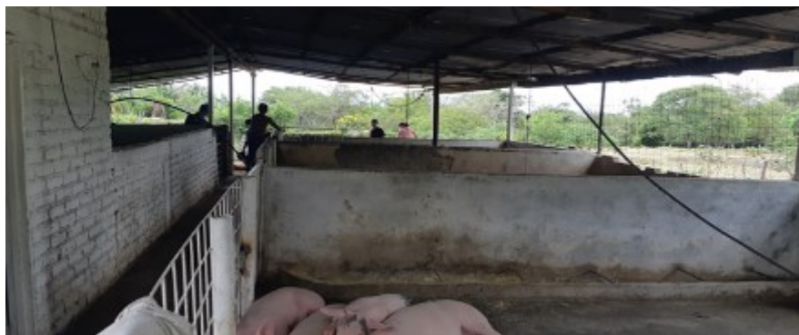
Foto 3. Se observan los corrales ocupados en la actualidad
