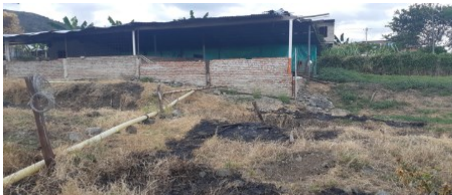
Foto 2. Se observa la tubería que conde las aguas de lavado y excretas de la explotación porcícola sin ningún tipo de tratamiento previo al cauce de la acequia.
