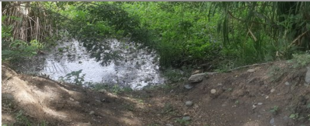
Foto 1. Se observa el nivel de las aguas en la madreveja con respecto al nivel de la cota de fondo del canal de acceso a la tubería que permite el flujo hacia el canal de drenaje.
