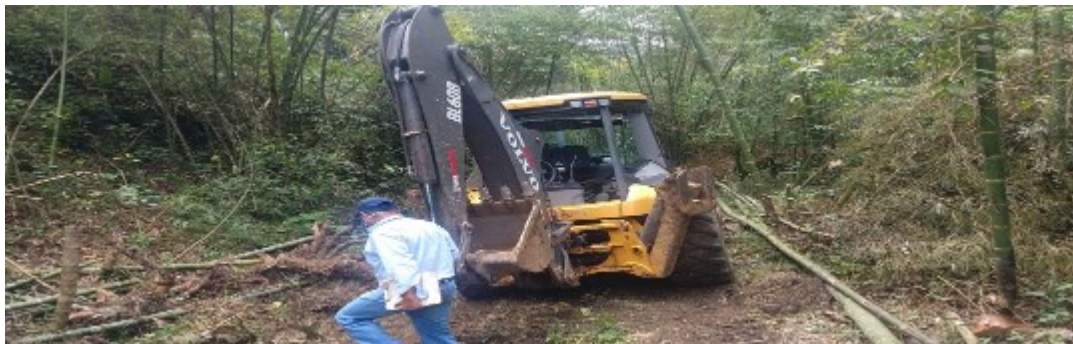
Foto No. 1 y Foto No. 2 se evidencia la maquinaria utilizada en la actividad.
