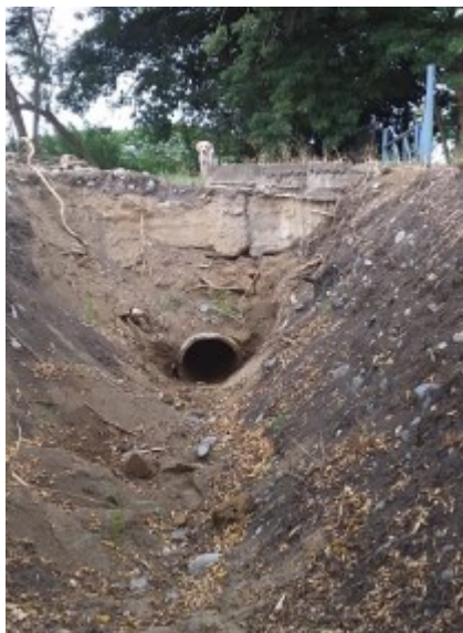
Fotos 6. Se observa el restablecimiento total del flujo.
