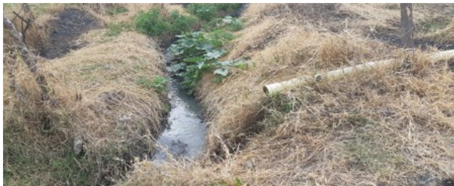
Foto 1. Se observa el punto de vertimiento al cauce de aguas.
