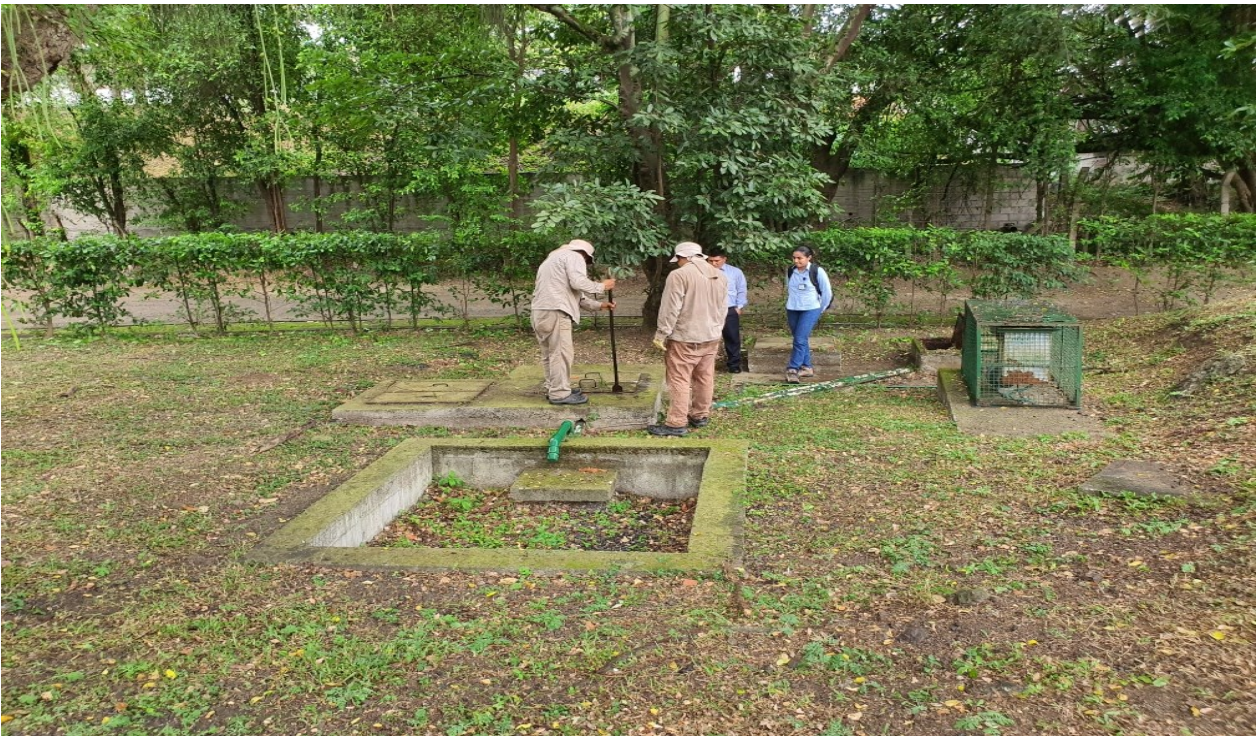
PTARD por fuera de operación
