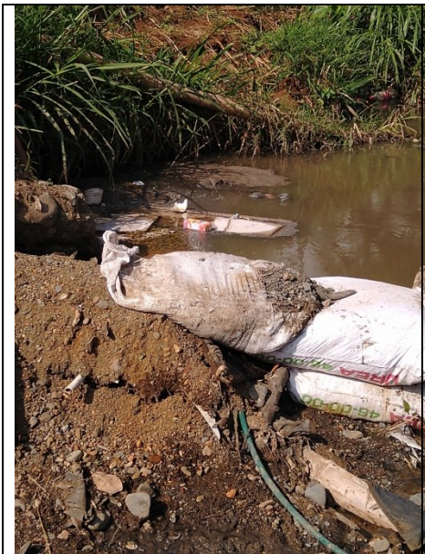
Taponamiento Rio Yumbo, con costales de tierra
