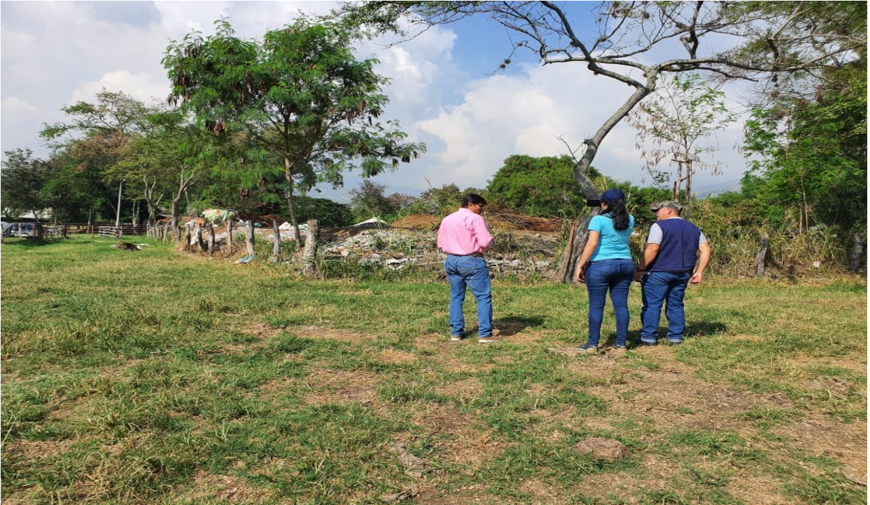
Movimiento de tierras y rellenos con escombros en la franja forestal del río Yumbo predio del municipio de Yumbo
