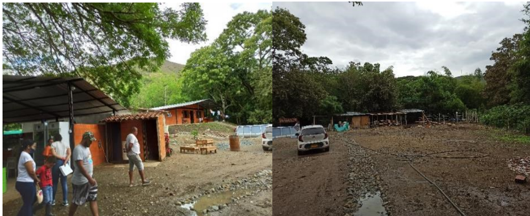
Imagen 3 y 4, Nivelación del predio y estructuras construidas, fuente propia.
