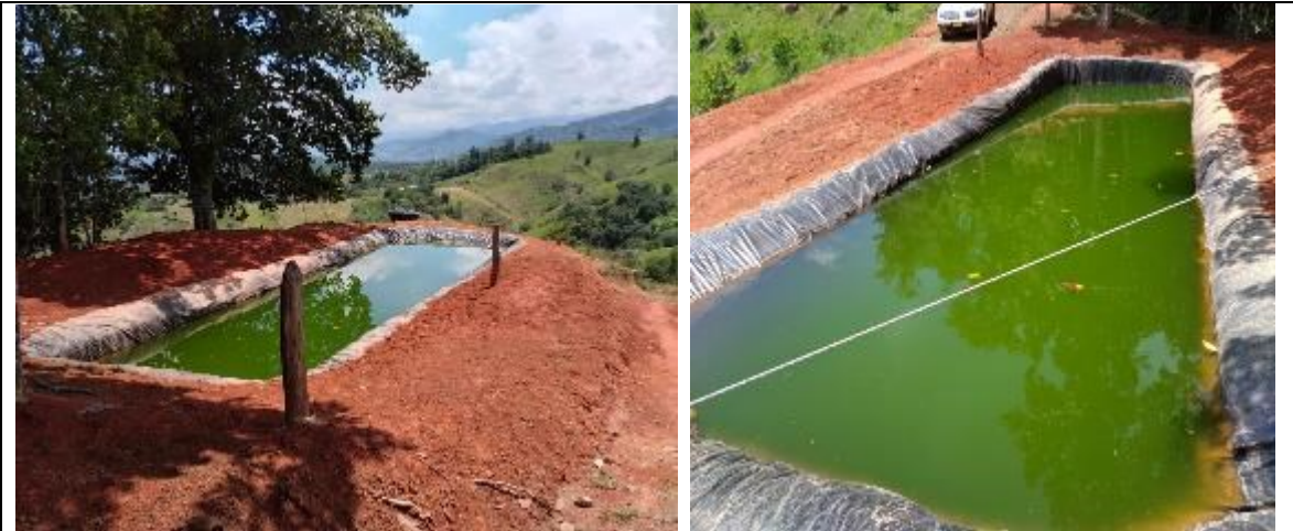
Fotos 3 y 4: reservorio construido.
