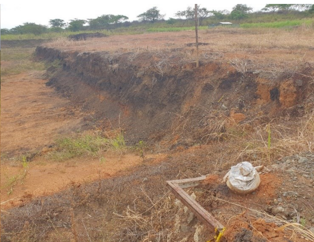
Foto 4. Talud dejado por la anterior excavación en el predio. CVC. 2019
