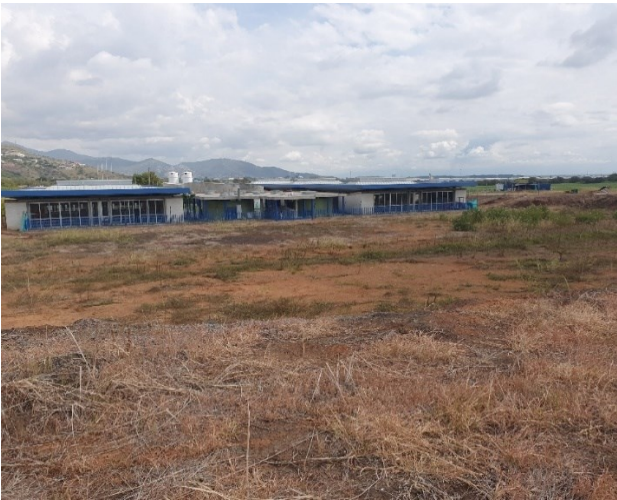
Foto 5. Al fondo se ven las aulas ya construidas. CVC. 2019
