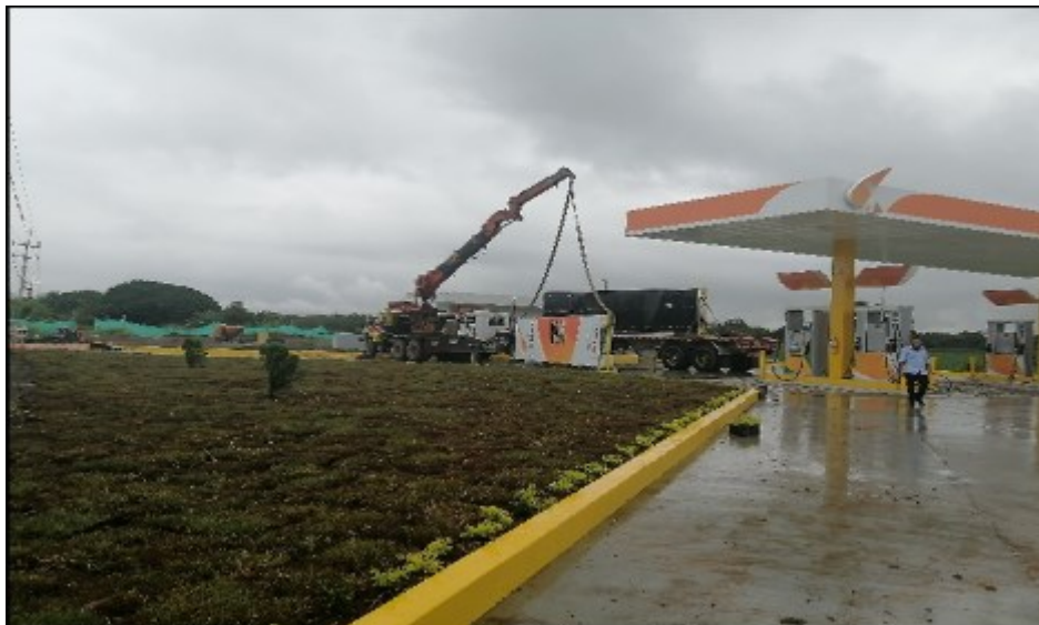
Figuras 5. Instalación del tablero de información de la EDS predio rural La María.
