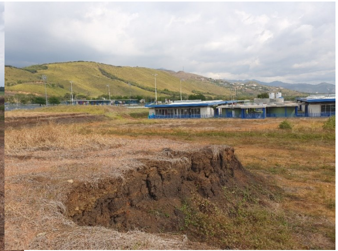
Foto 6. Se ampliará la zona para construir más salones o aulas. CVC. 2019
