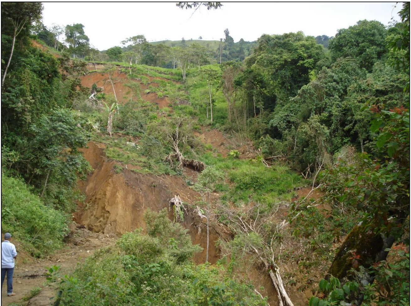
Fotografía 3. Deslizamientos activos en la Vereda Mateguadua, Municipio de Roldanillo, un factor importante en la activación es el inadecuado uso y manejo de los suelos en pendientes moderadamente fuertes. Cierre total de la vía interveredal.
