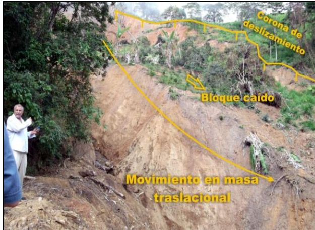
Foto 1 Deslizamiento que tiene incomunicada a las familias que habitan la vereda Mateguadua. Fuente: VEI&A Enero 18 de 2012
