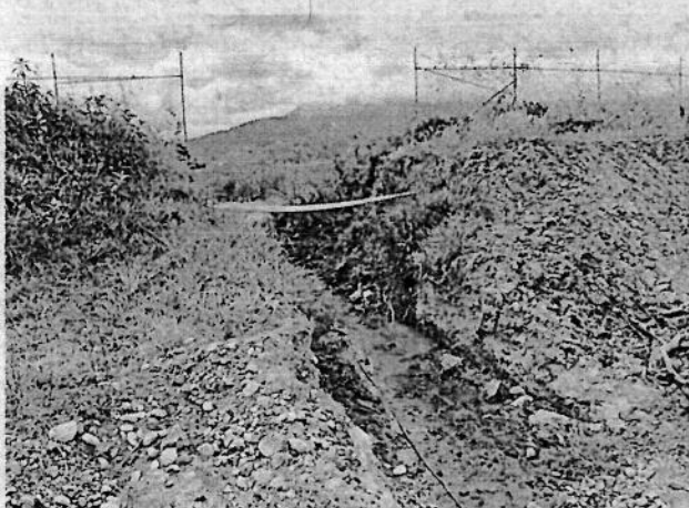
Estructura de terraplen abierta con tubería.
