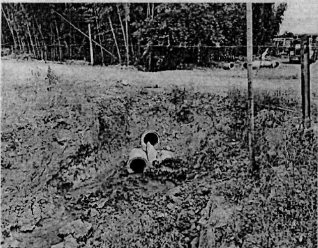
Tuberias bajo carreteable, una quebrada.
