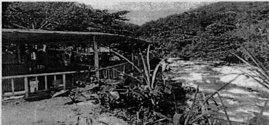
Registro fotográfico 2. Se observa las construcciones u obras efectuadas sobre el margen izquierdo del rio Bolo (ocupación de cauce e invasión de zona forestal protectora margen izquierda del Rio Bolo) del sitio intervenido pro los señores RAUL ALBERTO BUENO SALAMANCA identificado con cedula de ciudadanía No. 16.259.285 y GERMAN ARANZAZU con cedula de ciudadanía No. 94.311.372.
