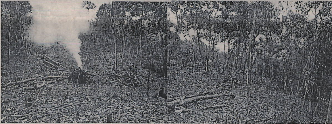
Imágenes 5 y 6. Tala rasa y quema en la parte posterior del lote y limpieza en el área cercana a la vía.
