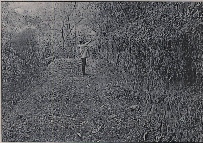
Imagen 8. Medición de los cortes de talud realizados
