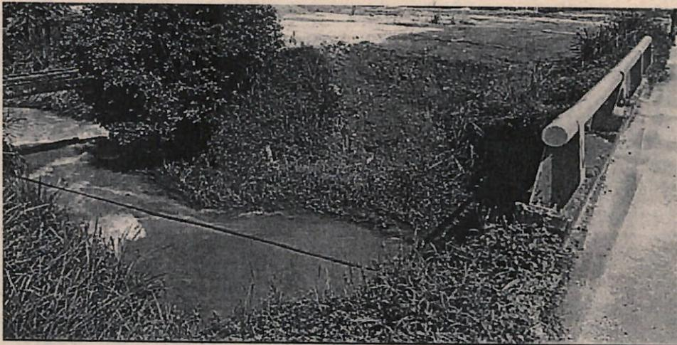
Zanjón Rosario. Se observa que parte del material se está rodando hacia el cauce natural del Zanjón, reduciendo su capacidad hidráulica. Mayo 2 de 2016 Hora: 14:30
