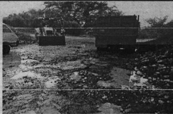
Fotos 2. Se observa la excavación mecanizada que supera la cota de fondo del cauce
