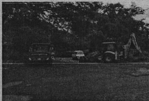
Fotos 1. Se observa maquinaria pesada extrayendo material de construcción en el sitio.
