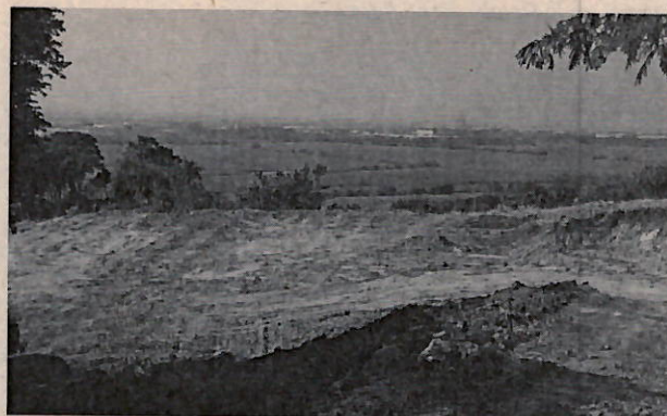
Ilustración 3 Explanación y corte de talud del lote 20
