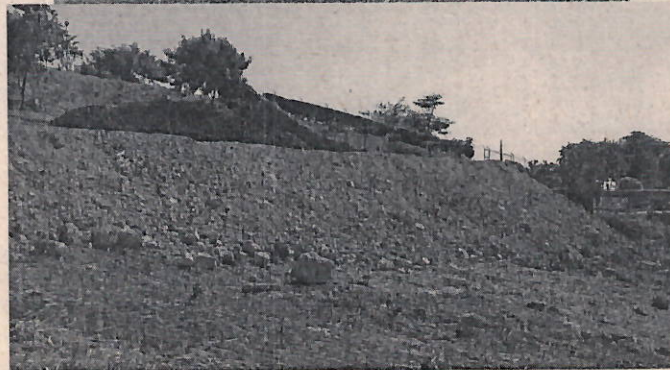
Ilustración 4 Relleno del lote 20 con una altura aproximada de 2m, con material de roca muerta.
