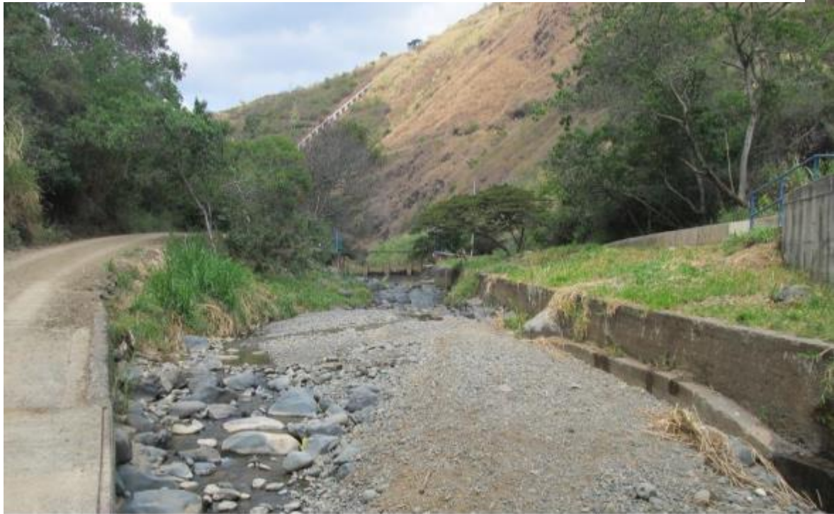
Figura 23. Aspecto del río Cali en el sector del Jardín Botánico de Cali
