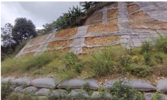
Foto 23. Estabilización y revegetalización de Talud – Mpio de Toro. Archivo CVC 2021.
