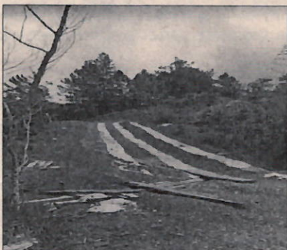
Imagen 3. Vía con placa huella y canales interseccionados
