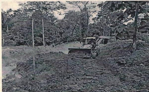
**Imagen 3** Durante la visita se pudo evidenciar la remoción de suelo con maquinaria pesada, nótese la demarcación del terreno con postes de la misma vegetación de la zona
