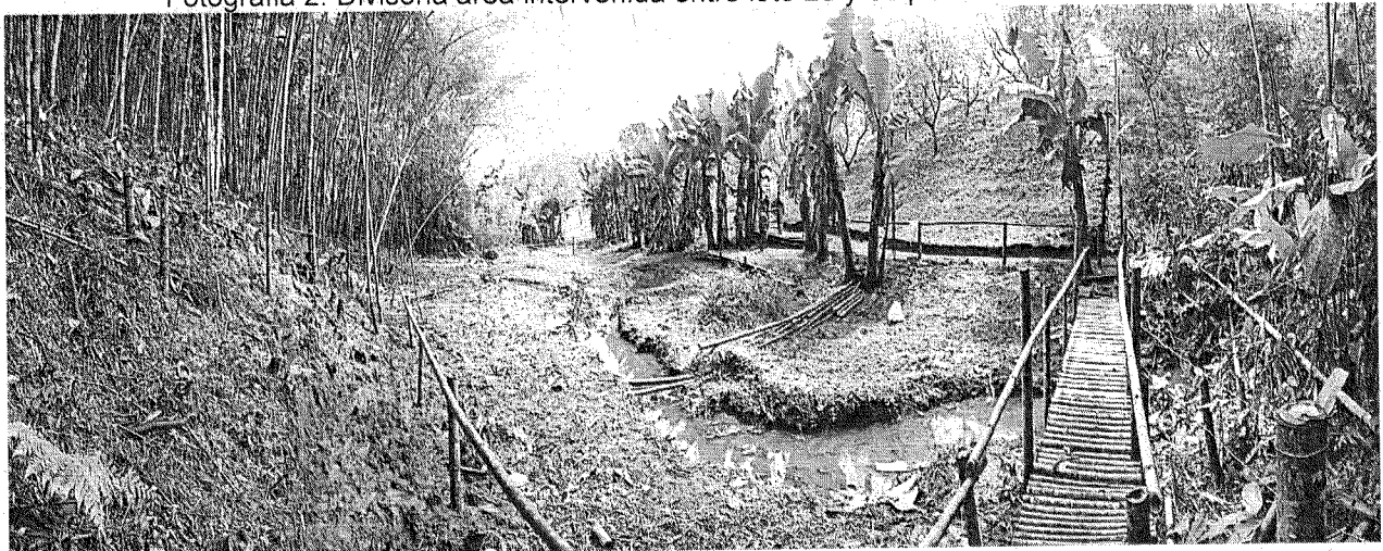
Fotografía 2. Divisoria area intervenida entre lote 28 y 30 parcelacion Villa Nueva
