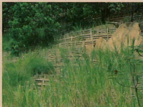
Construcción e Instalación de Trinchos de Madera para Estabilización de Laderas
