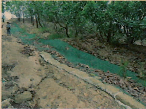
Instalación Muro Suelo Cemento
