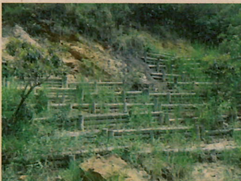
Construcción e Instalación de Trinchos de Madera para Estabilización de Laderas
