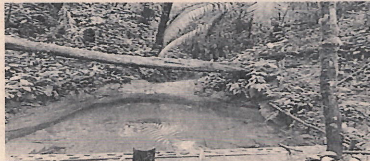
Foto 2. Piscina de captación
