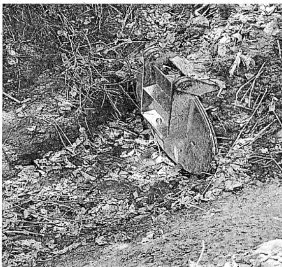
Foto No 2 Compuerta tipo Chapaleta localizada en el canal de entrega del humedal al Rio Cauca (fig. 5)
