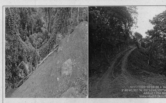
Foto No 3 y 4, se observa talud y la disposición inadecuada del material resultante de los cortes de la vía sobre la zona de alta pendiente lo que puede generar arrastre del mismo en épocas de lluvias fuertes y afectar la corriente de agua denominada El Loro en la parte baja.
