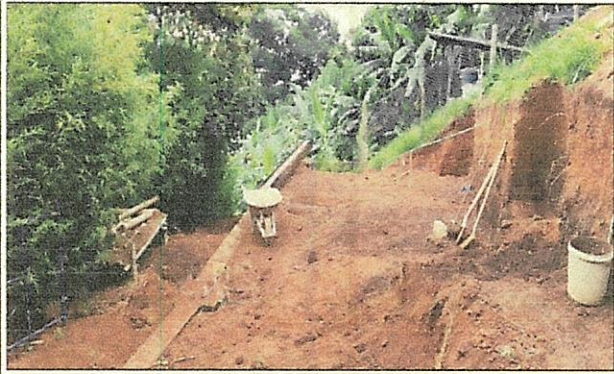
Imagen 2. Movimiento de tierra realizado
