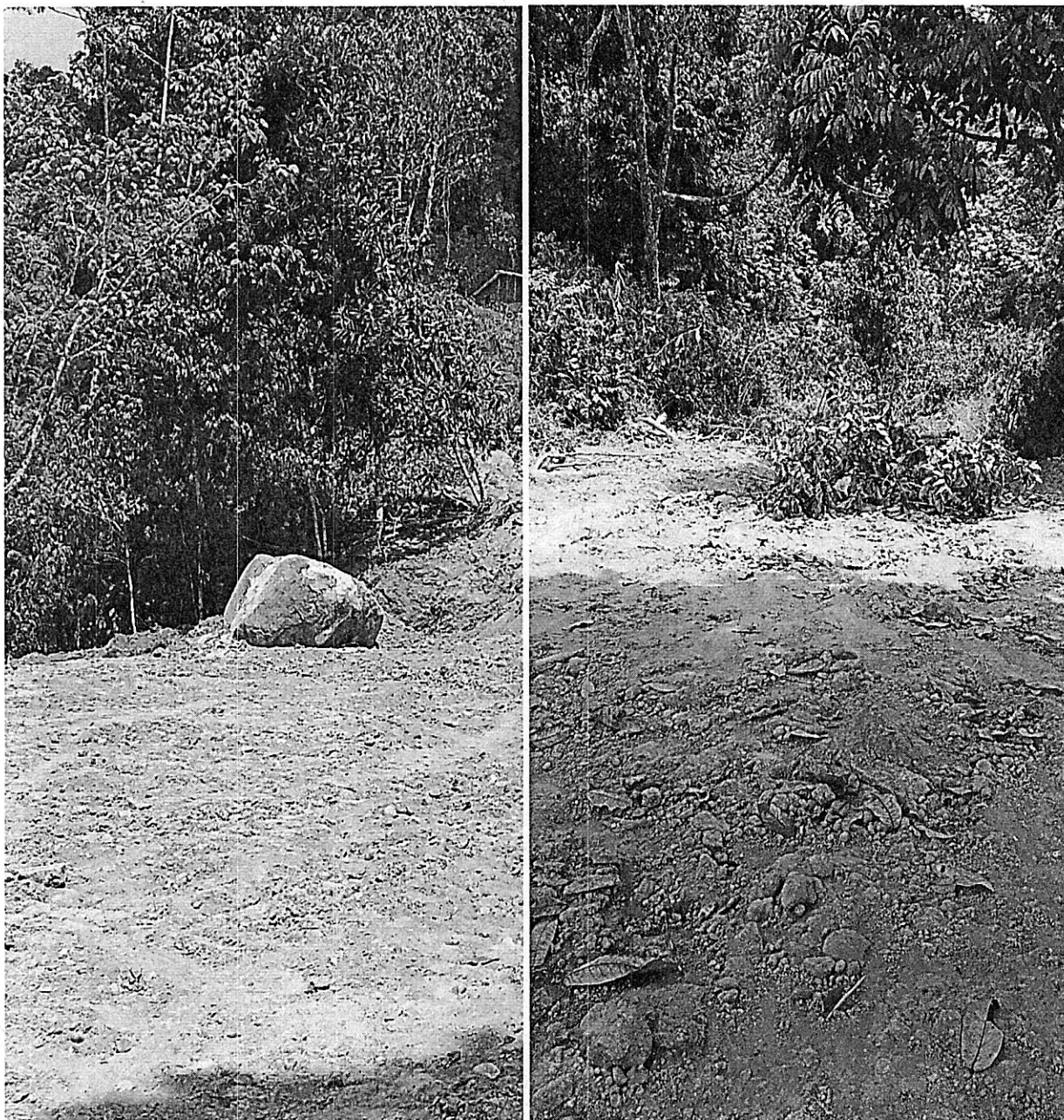
Foto 4. Piedras de sobre tamaño, arrojadas hacia la parte baja del predio, por donde hay un cauce natural.
