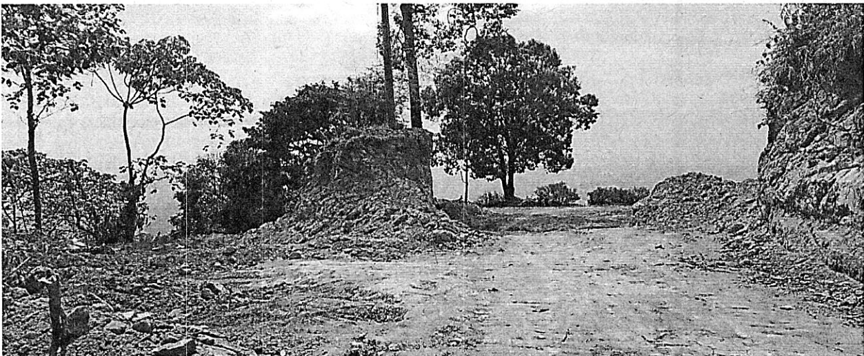
Foto 1. Entrada al predio. Explanación realizada con maquinaria pesada.
