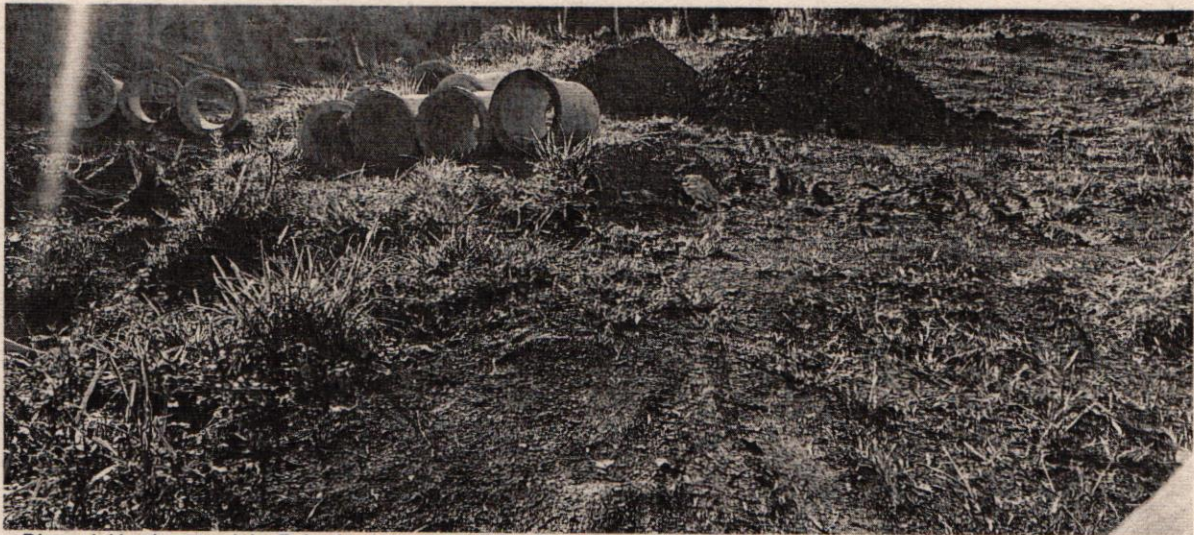
Disposición de material y Tubería al interior del Predio. Fotografía Tomada con Dispositivo Personal de Funcionario
