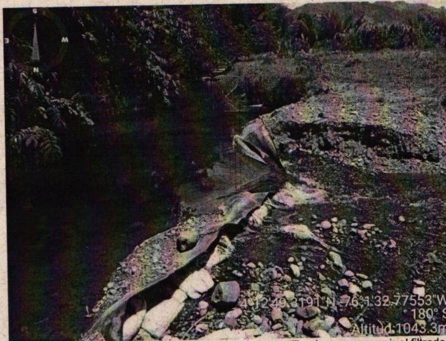
Foto 2. Aspecto actual de la atagüa donde se observa la lona utilizada para prevenir el filtrado del agua.
