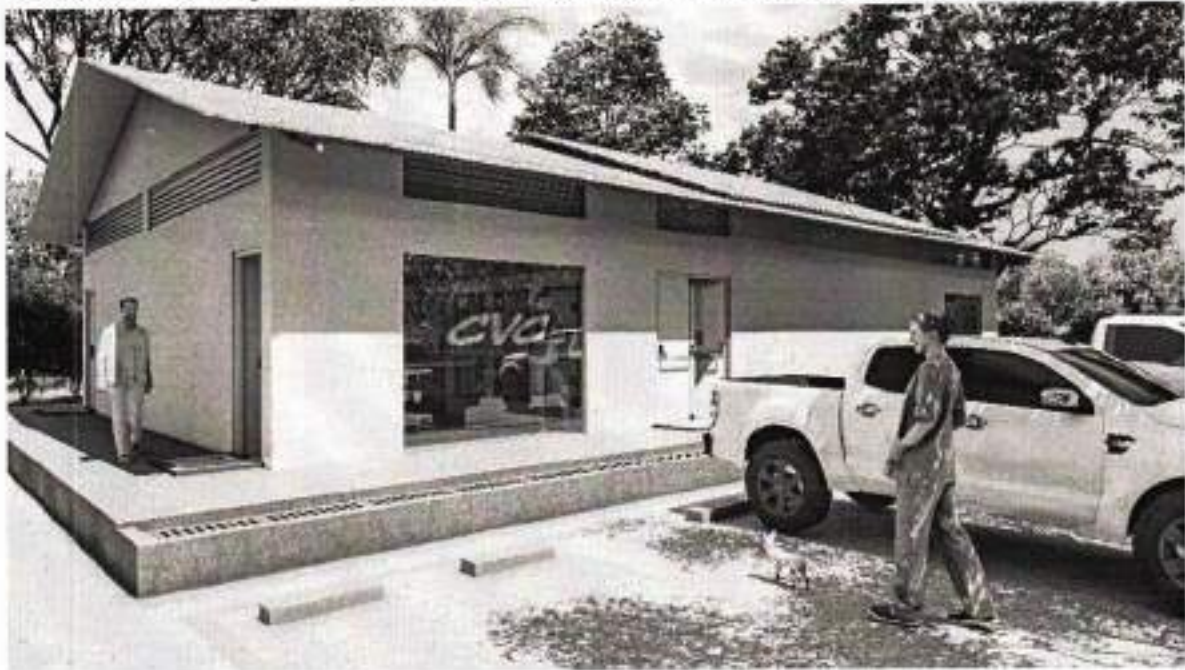
Ilustración 15. Mejora espacios centro educación ambiental San Emigdio
