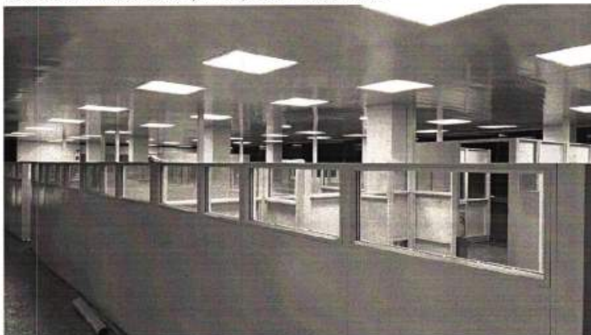
Ilustración 11. Adecuación primer piso edificio principal
