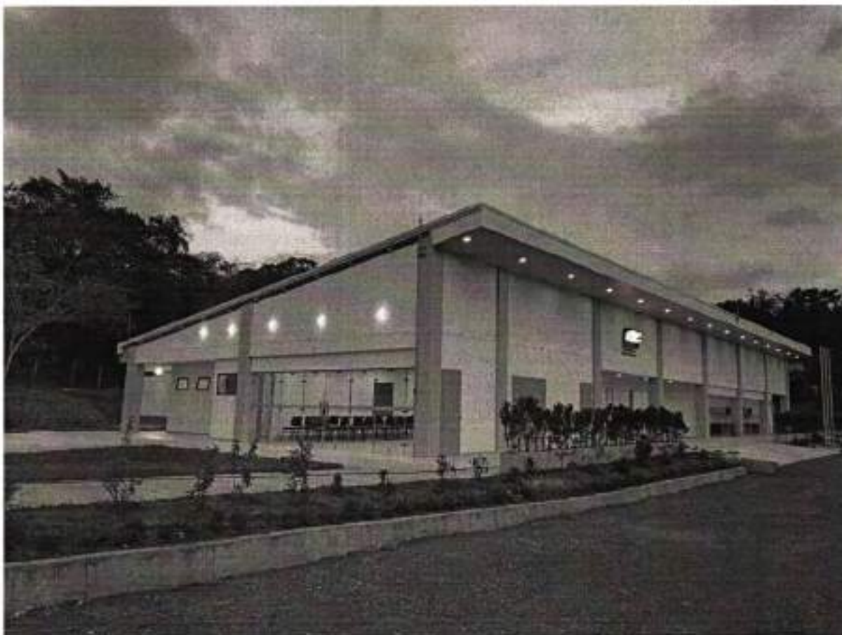
Ilustración 14. Construcción de la sede administrativa de la DAR Pacifico Este
