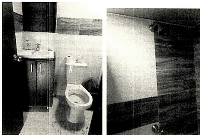
Foto N° 2. Unidad sanitaria tipo de cada habitación
