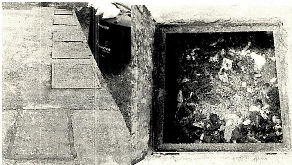
Foto N° 3. Planta general del sistema de tratamiento y entrada al tanque séptico.
