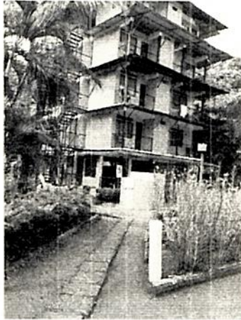
Foto N° 1. Tipo de bloque donde se ubican las habitaciones
