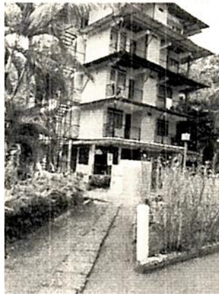
Foto N° 2. Tipo de bloque donde se ubican las habitaciones
