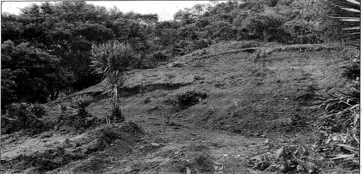
Foto 1. Vista general del movimiento de tierra realizado.
