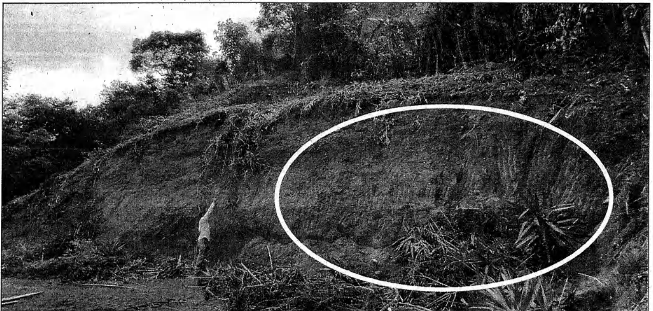
Foto 2. Vista de los taludes del terreno producto del movimiento de tierra con maquinaria pesada.
