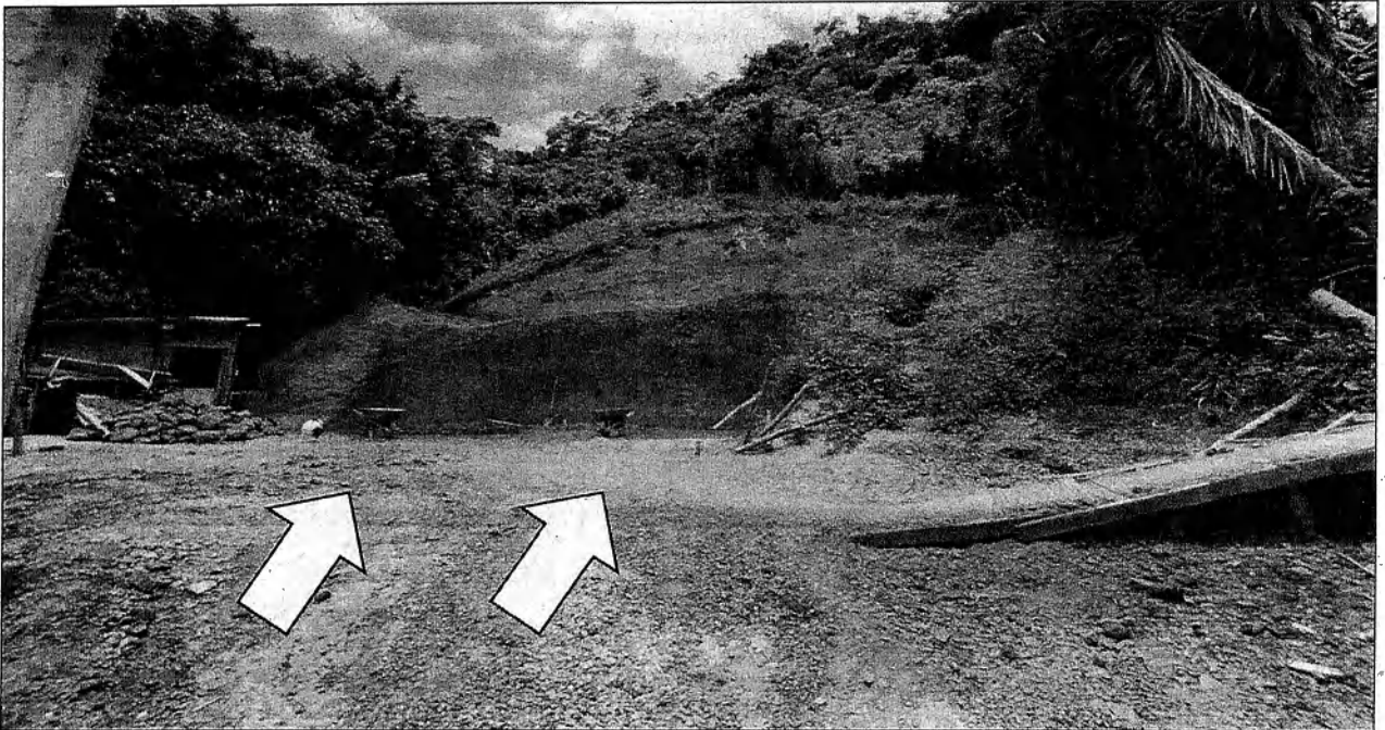
Foto 4. Vista de implementos de construcción y continuación de los movimientos de tierra.
