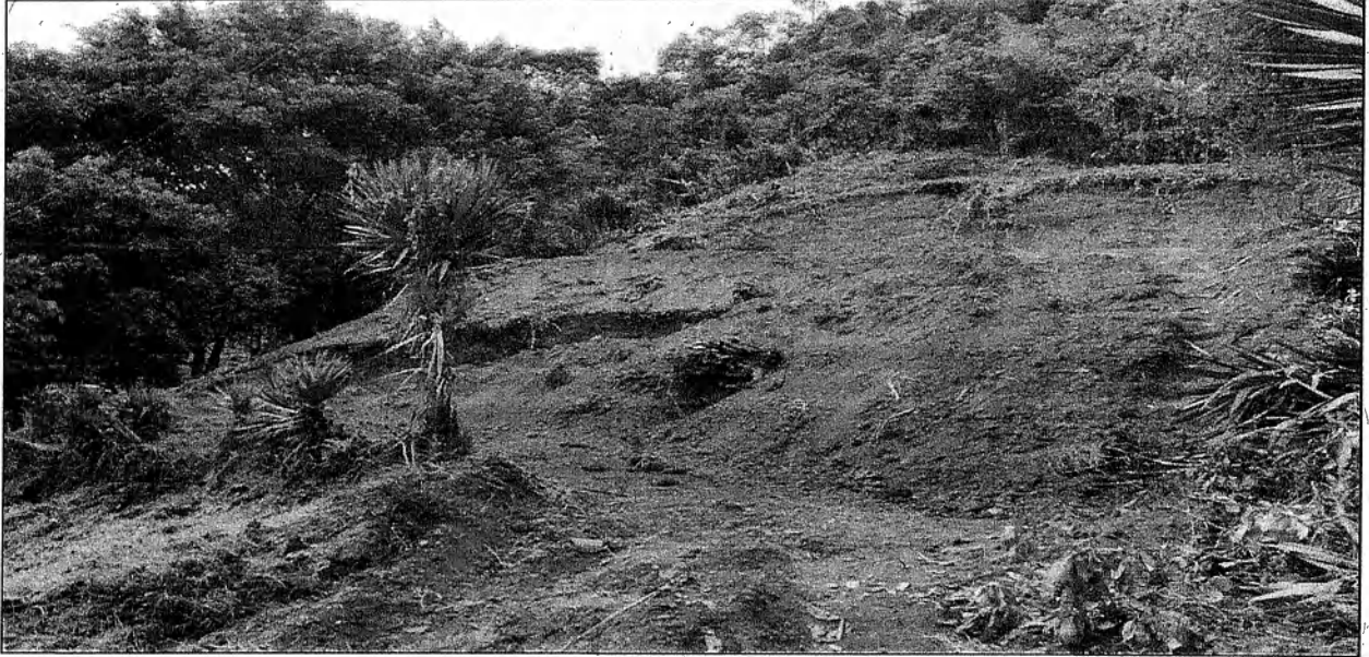
Foto 1. Vista general del movimiento de tierra realizado.
