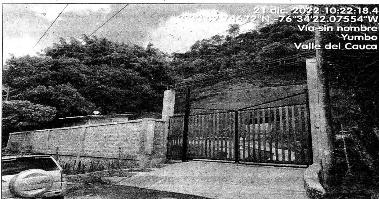
Foto 6. Vista del muro de cerramiento, puerta de acceso al Lote Sin Nombre y huellas en concreto para acceso vehicular.
