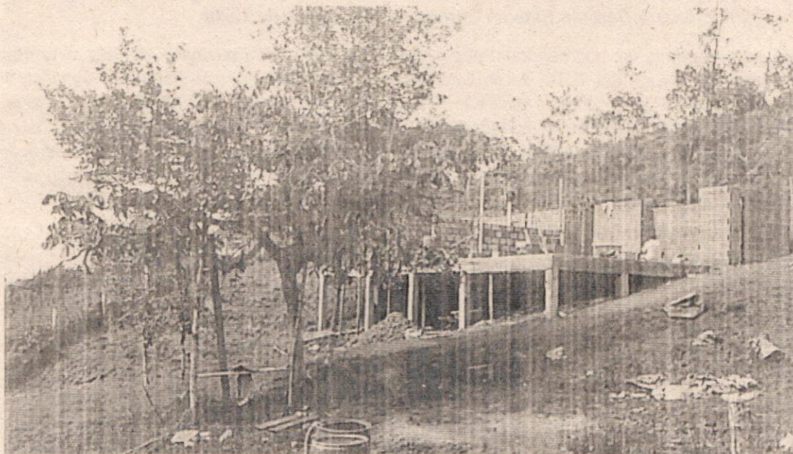
Imagen 1. Identificación de las actividades de Movimiento de tierra y construcción de vivienda encontrada. (Foto tomada con cámara celular del Funcionario German Estiven Garnica en Agosto 19 de 2020)
